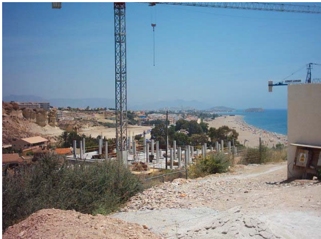
2- Obra nueva en Bolnuevo
