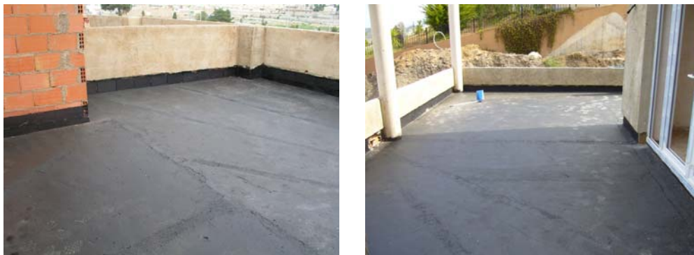
Imprimación total de la cubierta
