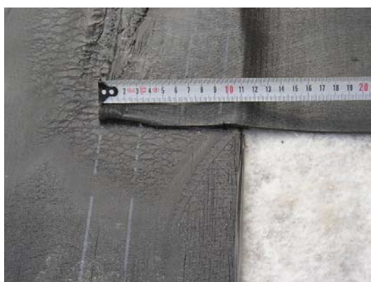
Solape de las láminas
