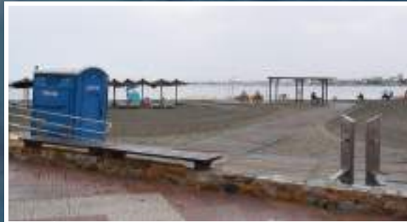
7 Rampa de acceso y pasarela
