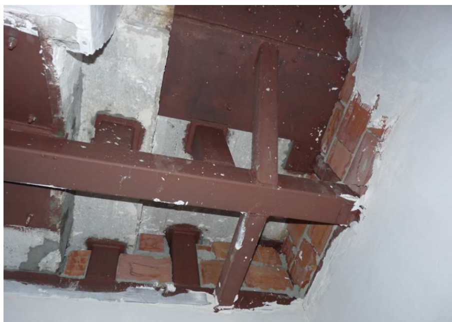
Figura A-2.8. Refuerzo de escalera mediante estructura metálica.
