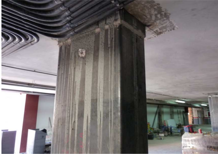
Figura A-2.3. Refuerzo con collarín metálico en la parte superior.
