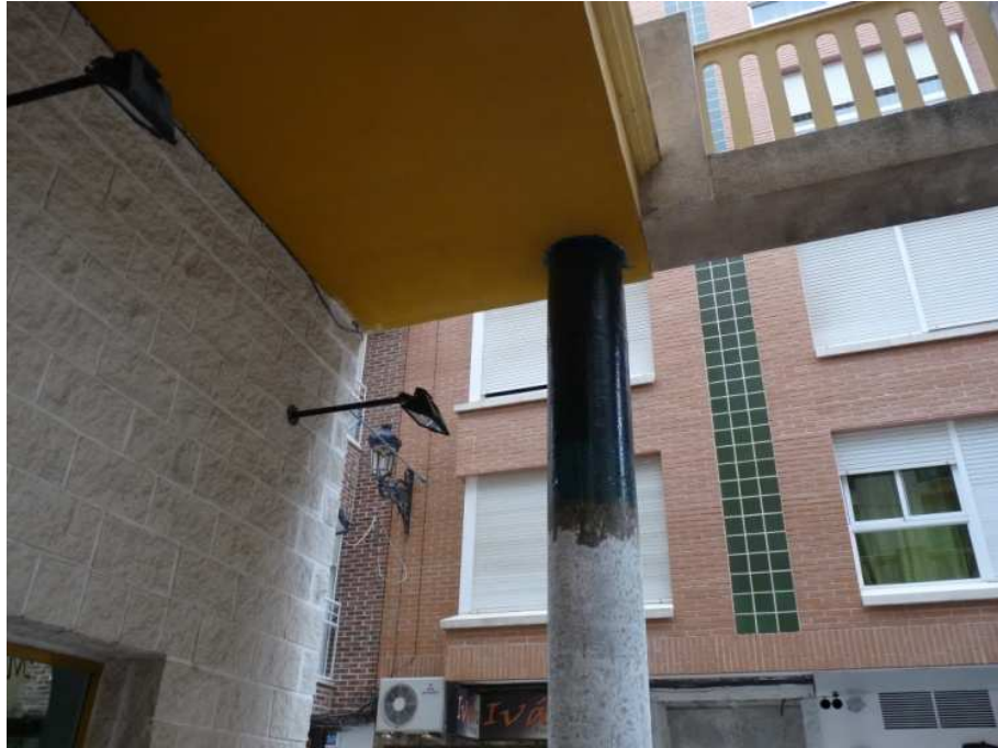
Figura A-2.2. Refuerzo por medio de fibras de carbono en pilar
