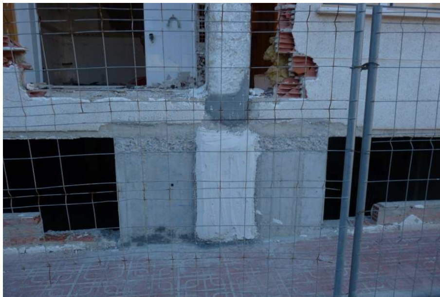
Figura A-2.7. Refuerzo de pilar corto por medio de adosado de muros de hormigón laterales.
