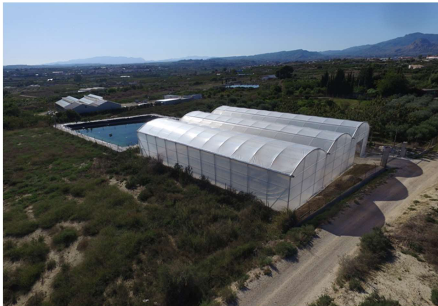
Ilustración 3: Panorámica exterior del invernadero y el reservorio principal
