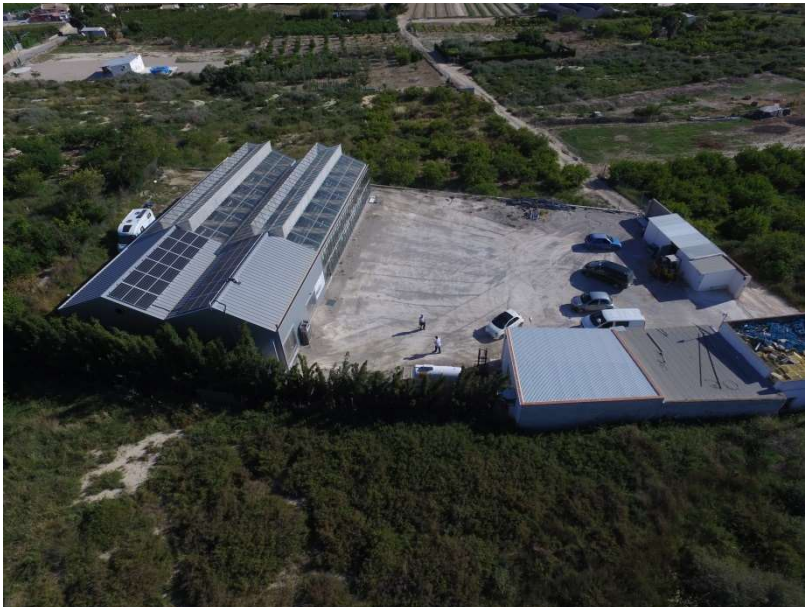
Ilustración 7: Panorámica general de la parcela 35 con las instalaciones descritas
