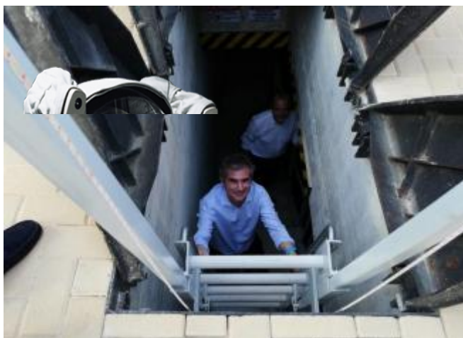
El consejero de Agua y Agricultura desciende a la tubería.
