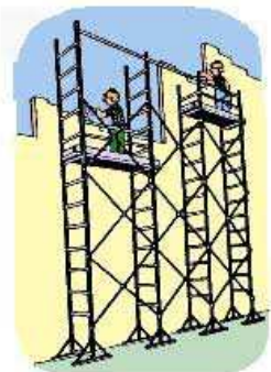
Imagen 2. Andamio de borriquetas vertical arriostado.
