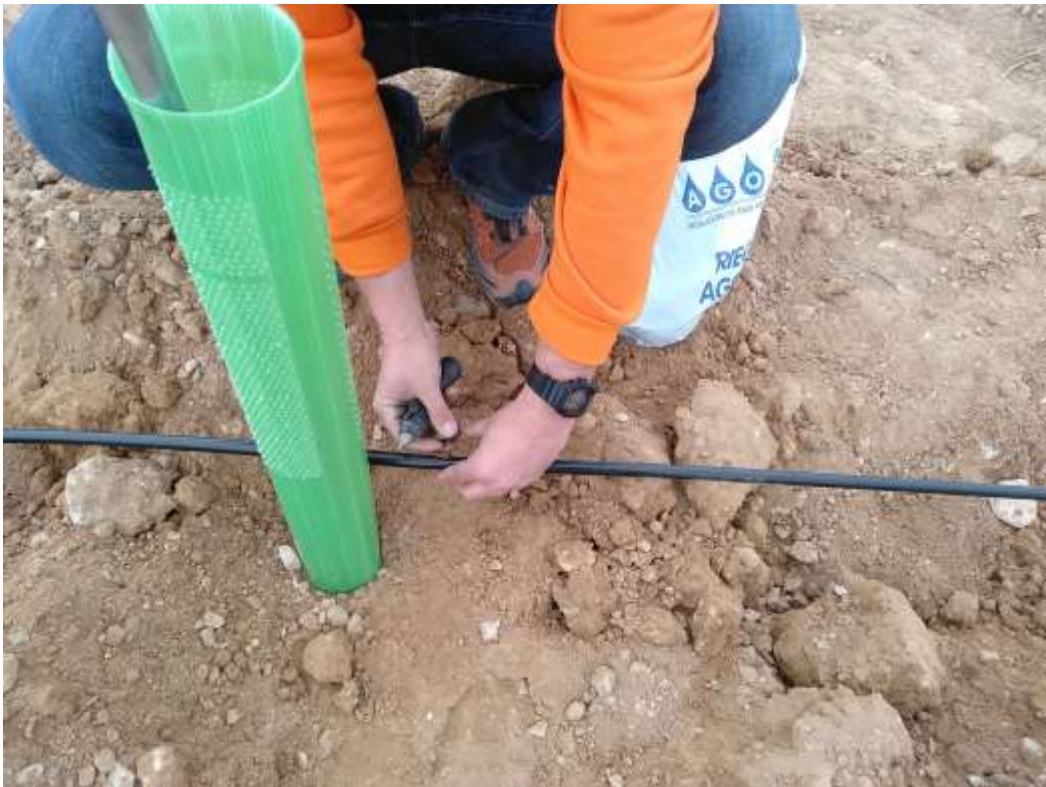
Foto 3: Extendido y pinchado de tuberías
