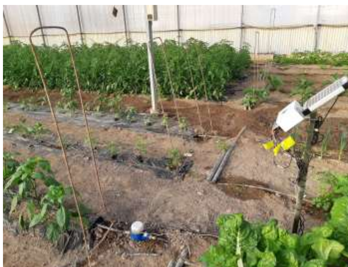
Foto nº 5. Sensores, caudalímetro, datalogger, transmisor de datos y placa solar (05/12/2019).
