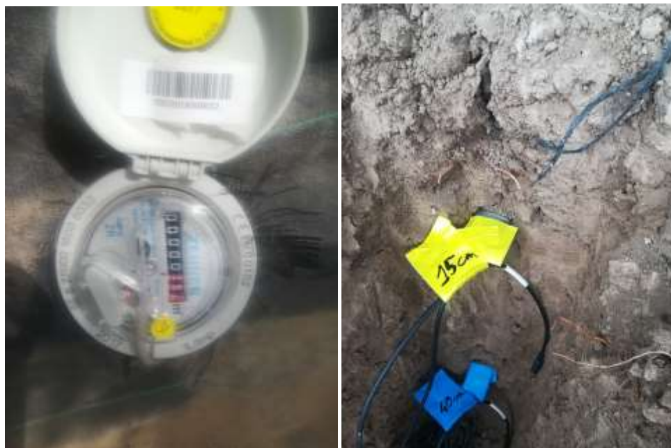
Fotos nº 6 y 7. Caudalímetro para tubería portagoteros y colocación de sensores a dos profundidades.
