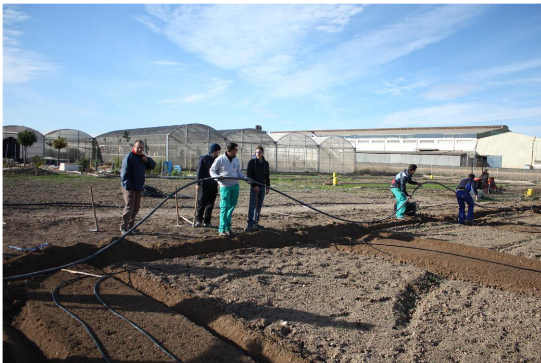
Foto nº 3. Aspecto de la instalación de riego para la plantación de almendros en febrero de 2017.
