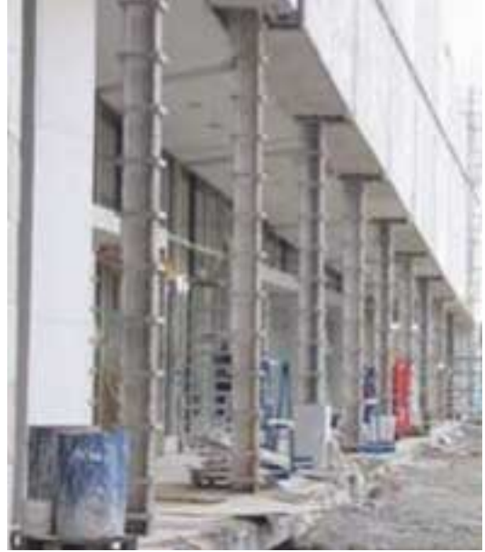
Estructura auxiliar en pilares
