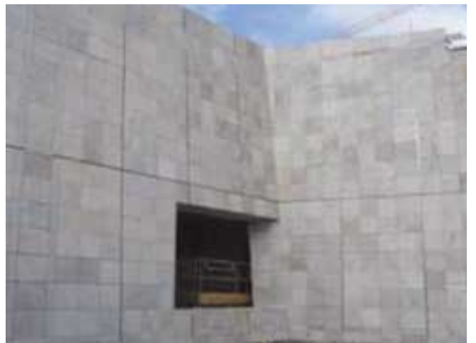
Fachada ventilada terminada
