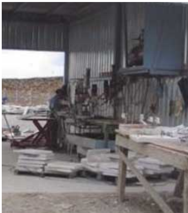
Taller de manipulación de piedra, con equipos de corte (piezas especiales) y taladro (anclajes químicos)
