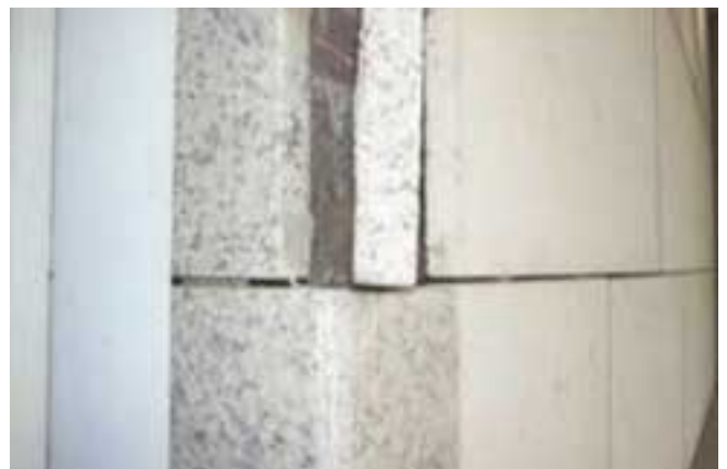
Pieza tan esbelta que gira por el eje del bulón
