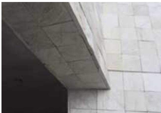
Fachada ventilada de cuarcita en la Ciudad de la Cultura. Santiago de Compostela. Arquitecto: Meter Eisenman
