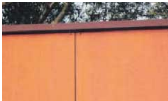
Remate superior con chapa correctamente ejecutado
