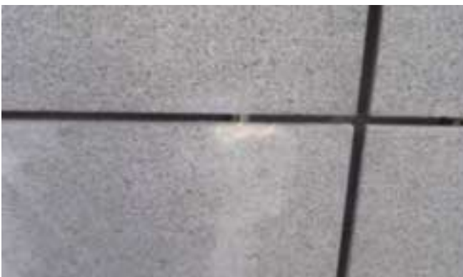
Reparación de placas a nivel de zócalo
