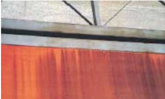
Un mal diseño a originado que el óxido de la perfilería metálica arruine el panel
