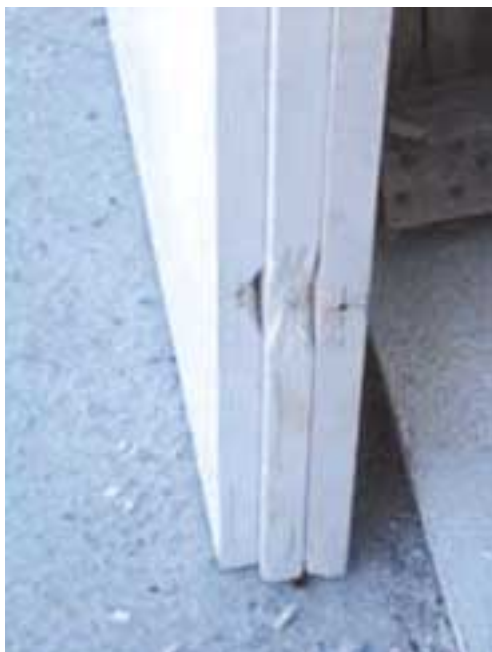
Taladros ejecutados en obra
