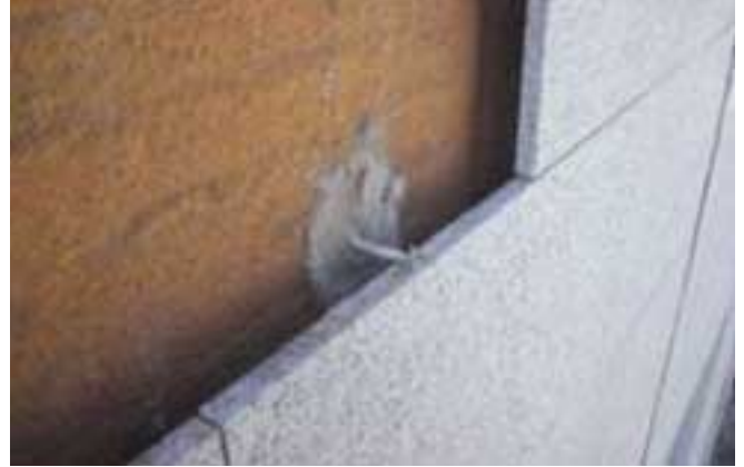
Único anclaje de fijación superior
