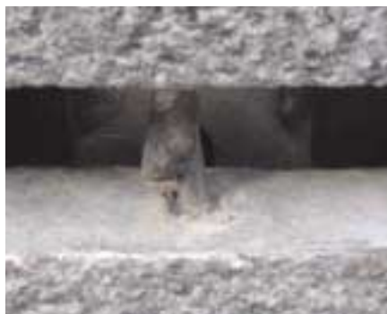
Bastago soldado para conseguir insertarlo en el orificio previsto
