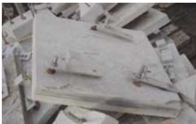
Anclajes y piezas de fijación colocadas en la baldosa
