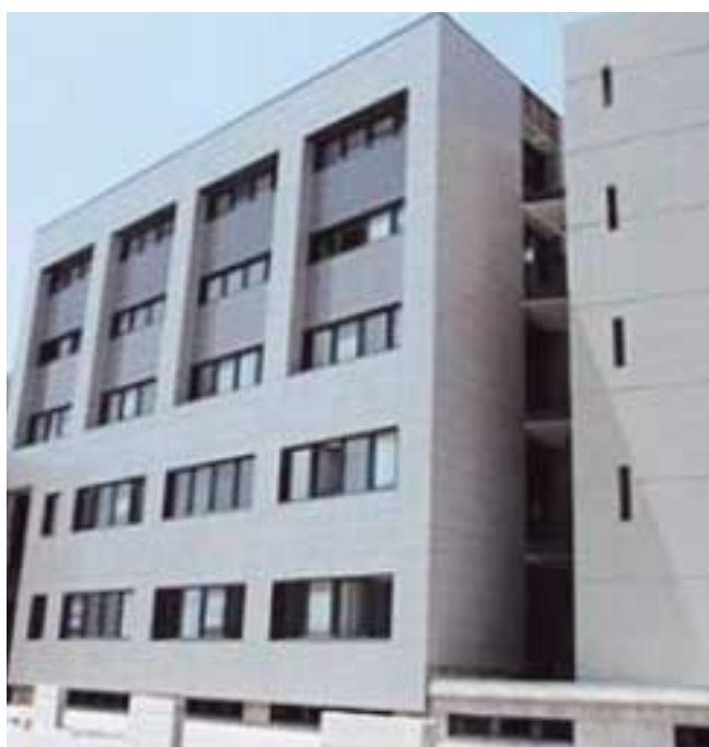
Edificio con fachada ventilada cerámica. Edificio de Ciencias Humanas y Sociales. Universidad Jaime I de Castellón (Cortesía de Tau Cerámica)
