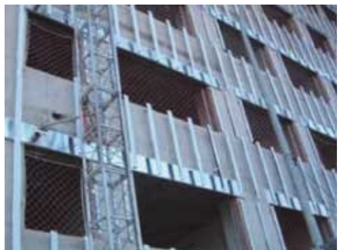
Colocación de Perfiles
