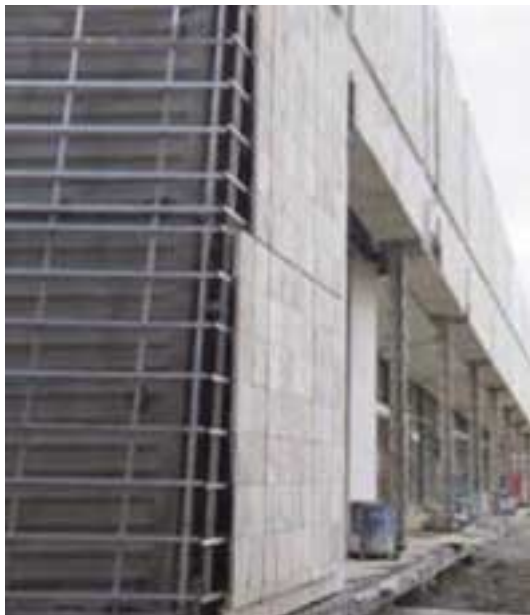
Estructura auxiliar en paños
