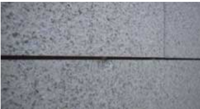
Rotura de la pieza por succión, como consecuencia de lo anterior
