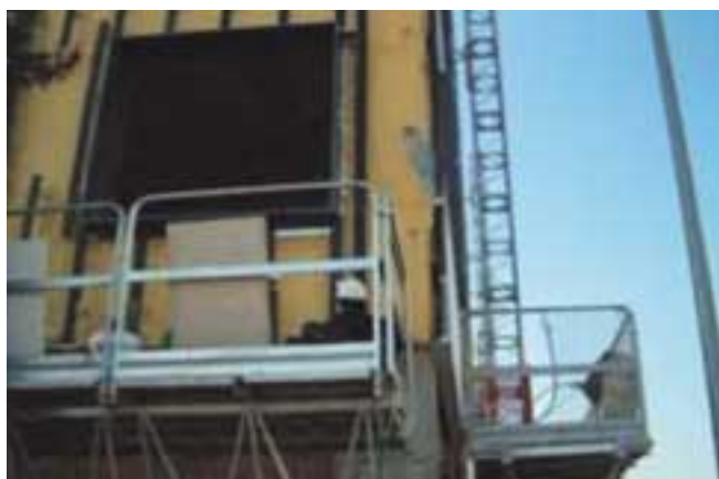
Colocación de las baldosas cerámicas
