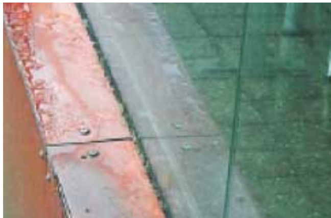
Si el vierteaguas tiene contrapendiente la entrada de agua esta asegurada
