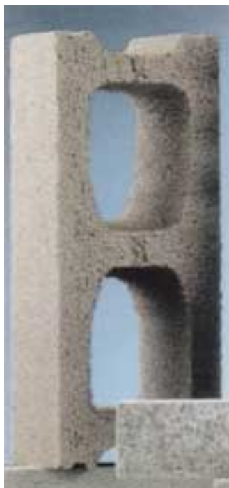
Ejemplo de un soporte no adecuado
