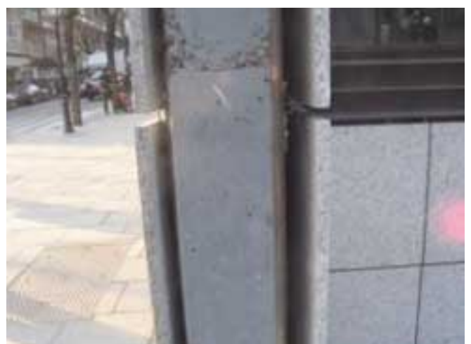
Anclaje mediante guía y anclaje tridimensional
