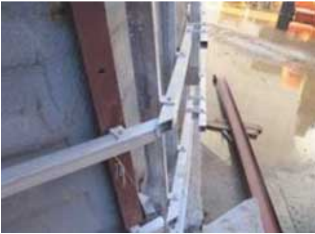
Estructura auxiliar de aluminio colocada
