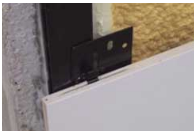
Colocación de la grapa
