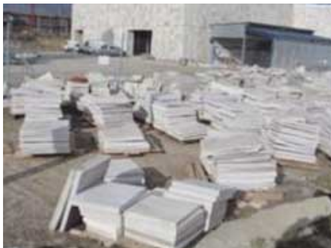
Acopio de piedra
