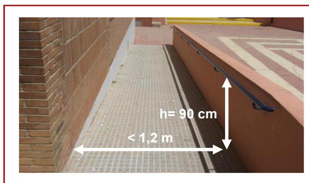
**FIGURA 2.** Ubicación de un pasamanos en rampa de anchura inferior a 1,2 m (rampa de acceso a pista polideportiva exterior).
