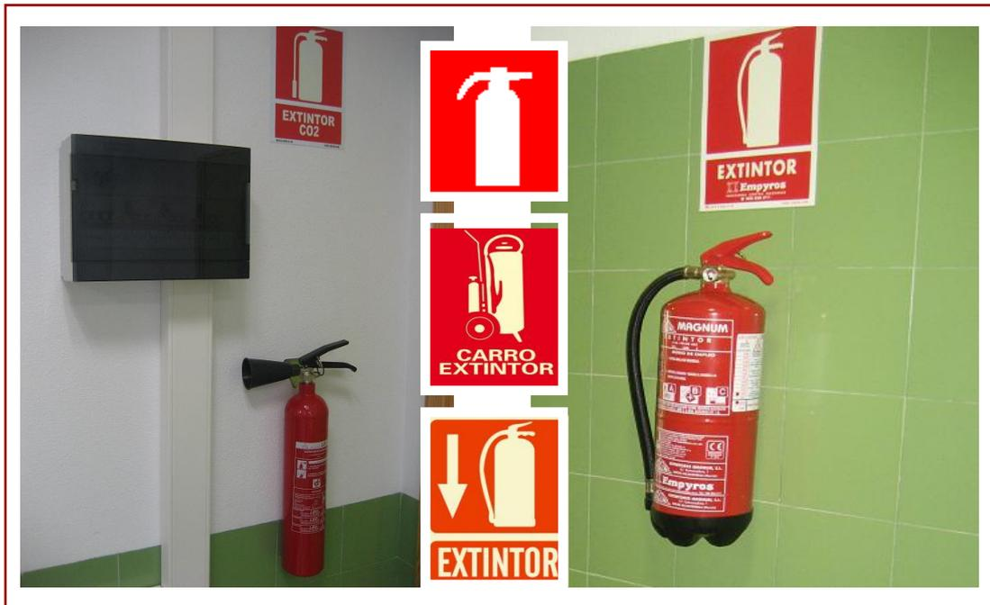
**FIGURA 16.** Extintores. Señales relativas a los equipos de lucha contra incendios.
