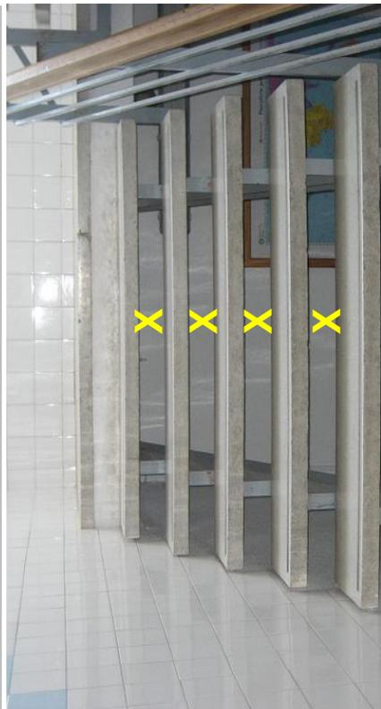
**FIGURA 10.** Contrahuella inadecuada (parcialmente inexistente), en centro público de “Pedanía” de construcción anterior a 1997.
