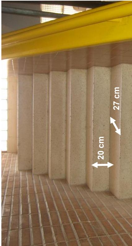
**FIGURA 9.** Huella y contrahuella de escalón, en escalera de un centro público de “Gran Casco”, de construcción anterior a 1997.
