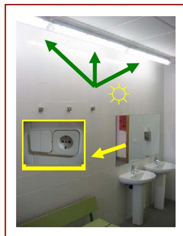
**FIGURA 23.** Luminarias adecuadamente instaladas y aisladas, en el aseo de un centro público que, sin embargo, presenta interruptor y toma de corriente cercanos al área de lavabos.
