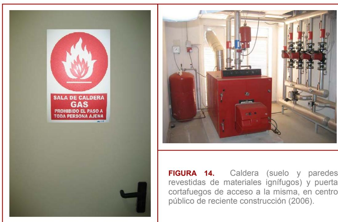
**FIGURA 14.** Caldera (suelo y paredes revestidas de materiales ignífugos) y puerta cortafuegos de acceso a la misma, en centro público de reciente construcción (2006).
