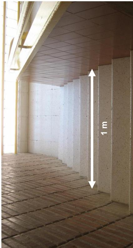
**FIGURA 8.** Anchura de escalera de un centro público de “Gran Casco”, de construcción anterior a 1997.
