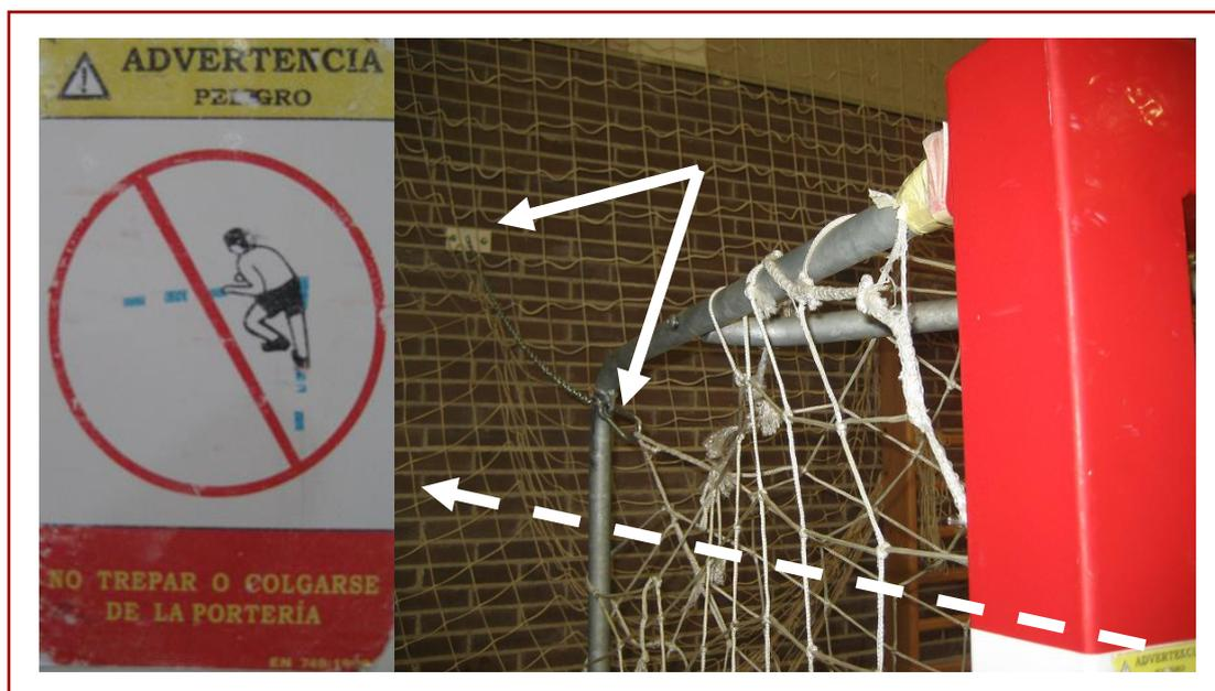
**FIGURA 25.** Sistema de fijación a la pared y señalización de peligro de caída, de una portería de balonmano en un pabellón polideportivo municipal de uso escolar.
