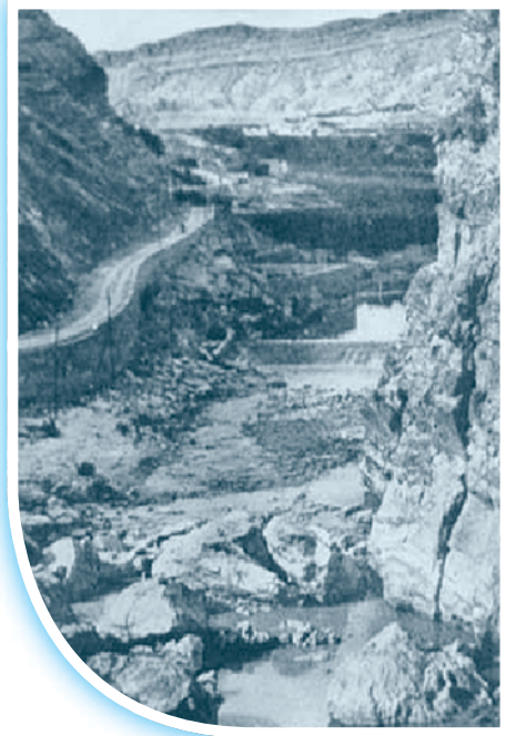
Vista del Azud
