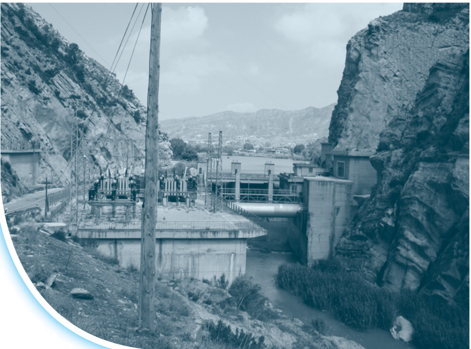
Infraestructura del Traspase Tajo-Segura en el Azud
