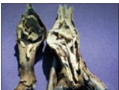
Daños de Xylotrechus en madera. Se ven las larvas.
