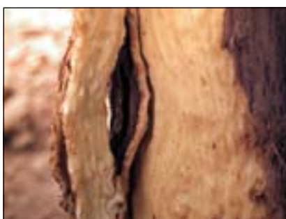
Madera rizada. Daños en corteza y madera.
