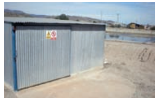
Caseta para cabezal de riego y almacenamiento de fitosanitarios y fertilizantes, separada de viviendas y granjas.
