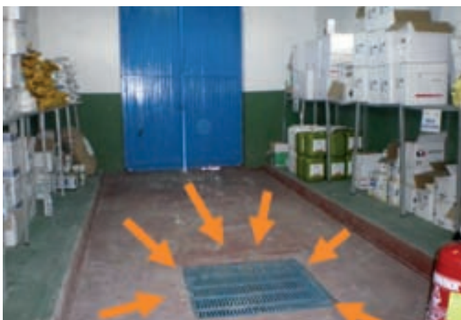
Almacén con colector de desagüe conectado a una fosa impermeable exterior.
