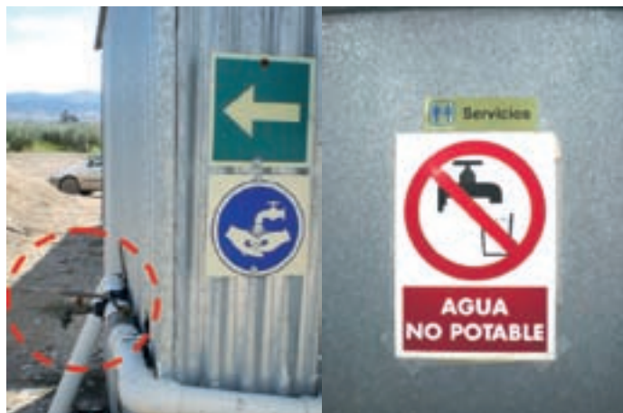
Señalización de agua apta para lavado de manos, indicar en caso de no ser agua potable.
