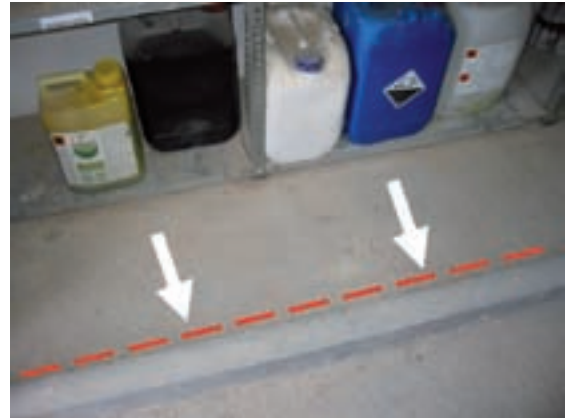
Reborde a modo de cubeto en estanterías para fitosanitarios.
