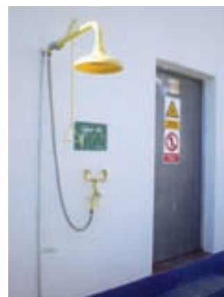
Ducha lavaojos en el acceso al almacén de fitosanitarios.
