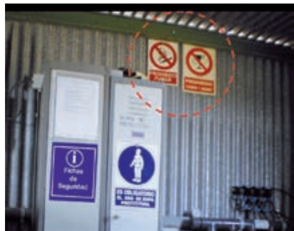
Armarios para guardar las fichas de seguridad de los fitosanitarios y los EPI, junto con la señalización de la prohibición de fumar, comer y beber.
