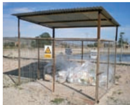
Espacio vallado y cubierto para almacenar envases vacíos de fitosanitarios.
