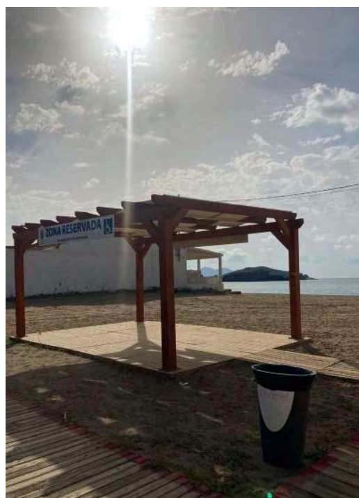
3_PASARELA Y ZONA DE SOMBRA
