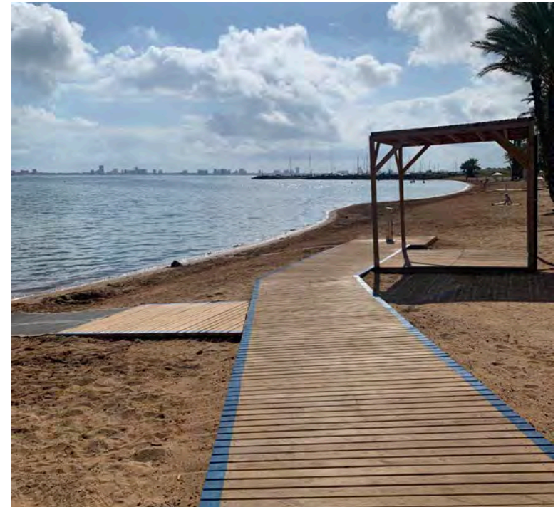
2.1_PASARELA Y ZONA DE SOMBRA
