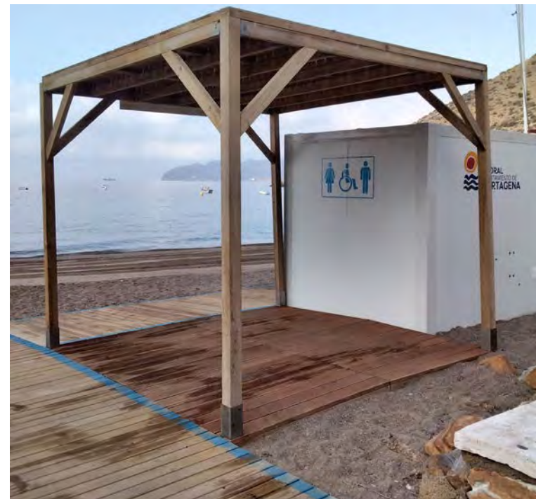
2_RAMPA DE ACCESO Y ZONA DE SOMBRA
