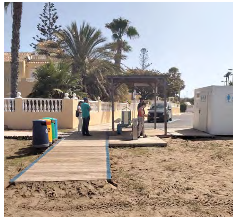
2_PASARELA, ZONA DE SOMBRA Y ASEO
