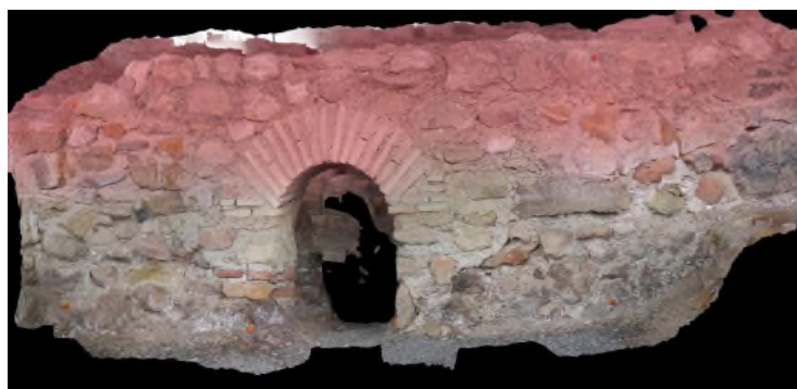
Ilustración 40: puerta principal del Caldarium .
