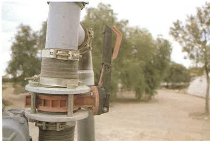
Detalle de la llave de regulación de alimentación del separador
