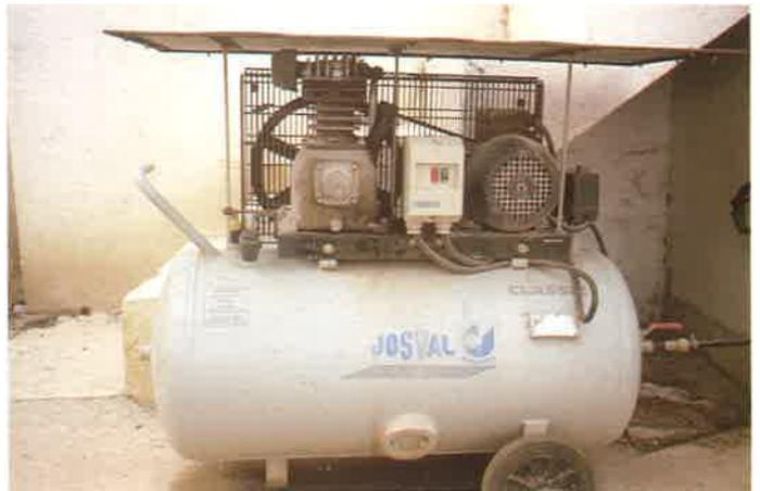
**Compresor de aire utilizado en el sistema de aireación de la Fase líquida**
