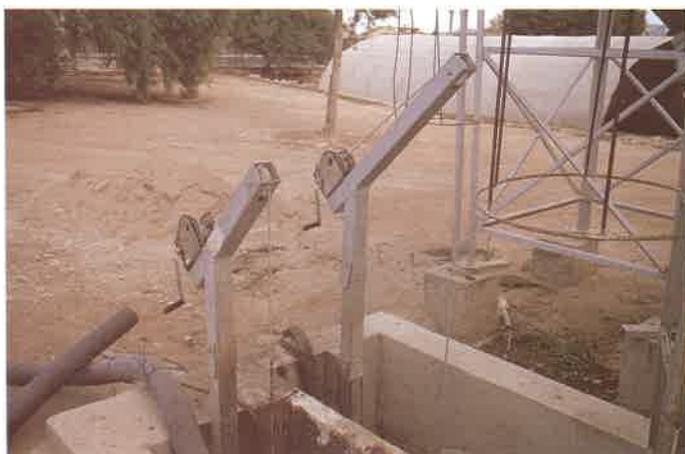
**Grúas para elevación de bomba de alimentación y de aireador**
