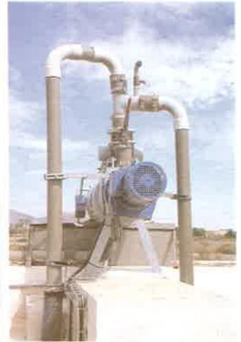
Vista posterior del separador de purines con las tuberías de alimentación del "compacter" y el sistema de retorno
