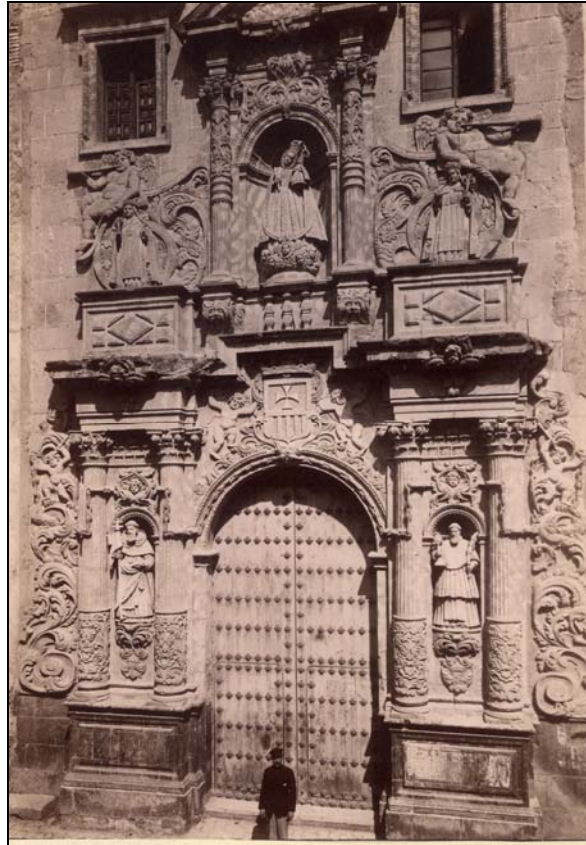
Figura 45: Fachada de la iglesia de La Merced (Murcia): 1905 –1907.
