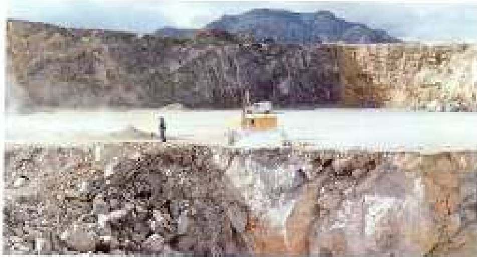
• Vista general del frente de explotación. En primer plano, las labores de apertura de un banco inferior.
