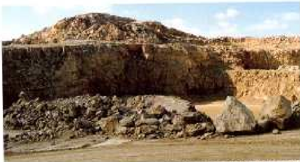
• Vista parcial, donde se pueden apreciar los planos de estratificación y la rotura a favor del diedrado subvertical definiendo bloques.
