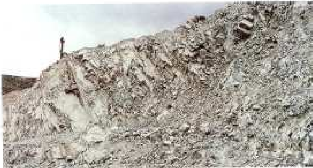
• Trabajos de perforación para voladura del banco. Se observa la fragmentación en bloques.
