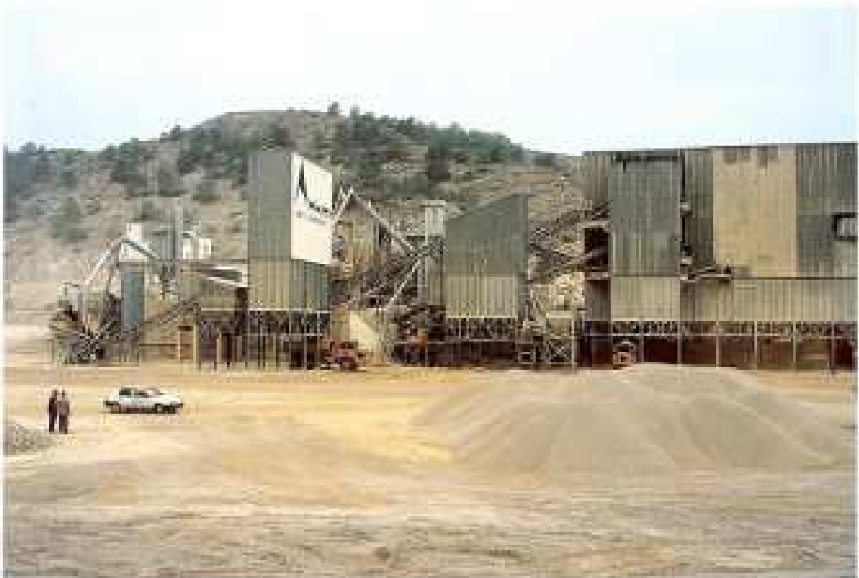
• Planta de tratamiento de áridos.
