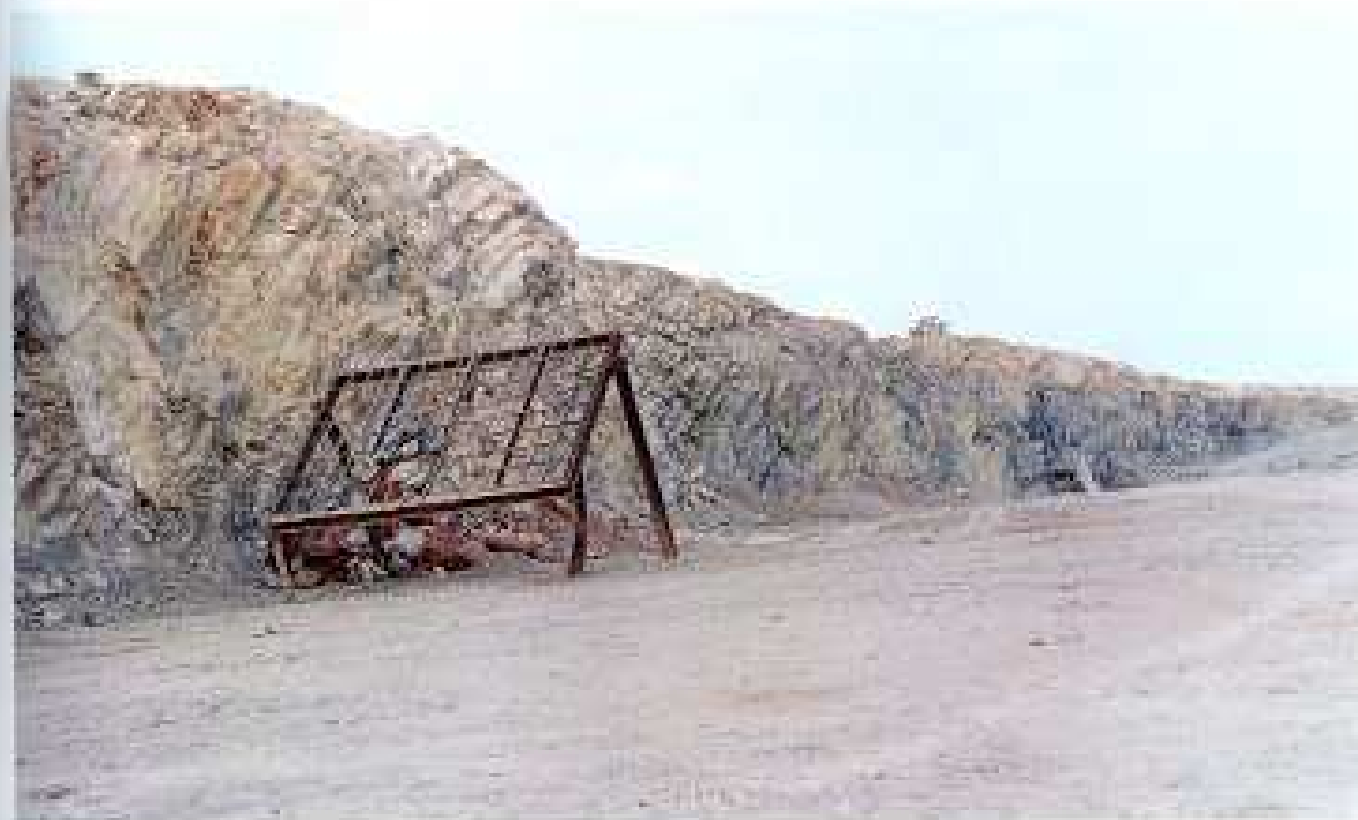
• Vista general del banco superior del frente en la que se observan los niveles tabeados de la zona superior que componen los materiales atravesados por la explotación.
