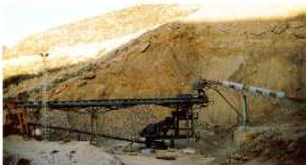
• Vista parcial de la planta de tratamiento.
