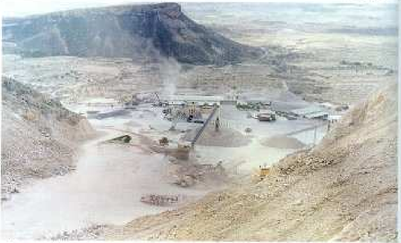
• Vista de la planta de tratamiento desde la cota del frente Sur.
