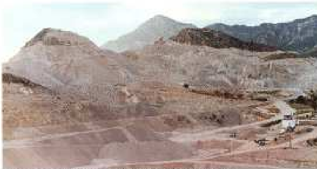
• Parte de la explotación situada al W del frente principal.
