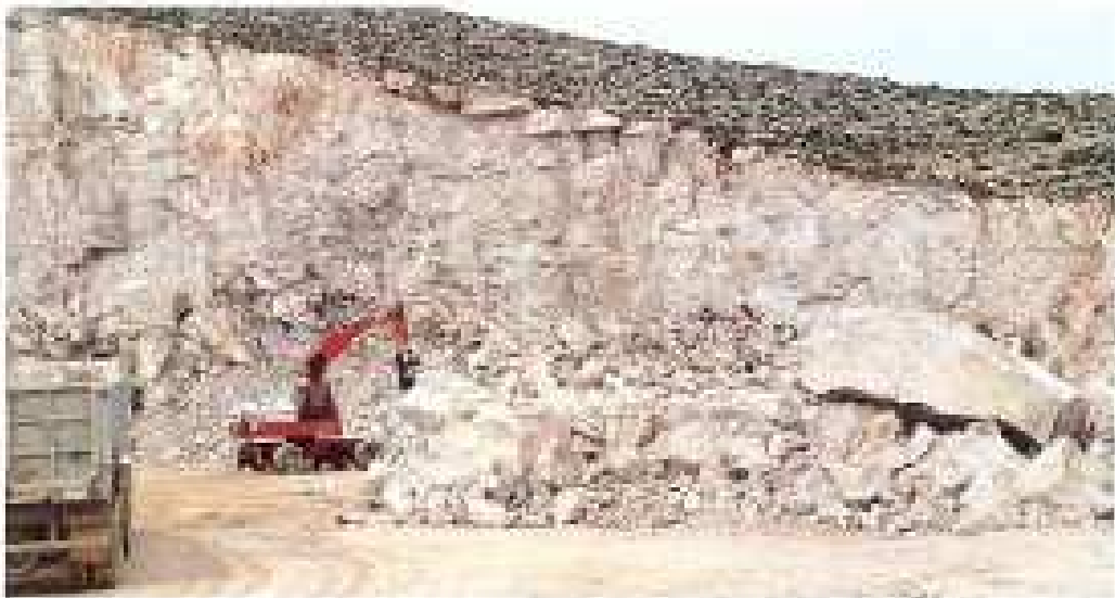
• Aspecto del frente con los fragmentos rocosos arrancados por voladura y reducidos mediante martillo picador.
