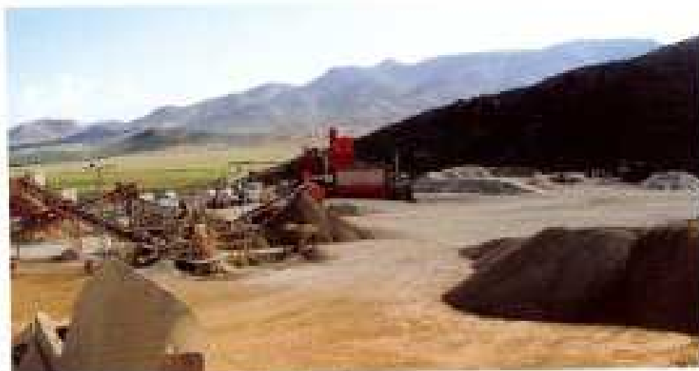
• Vista parcial de la planta de tratamiento.
