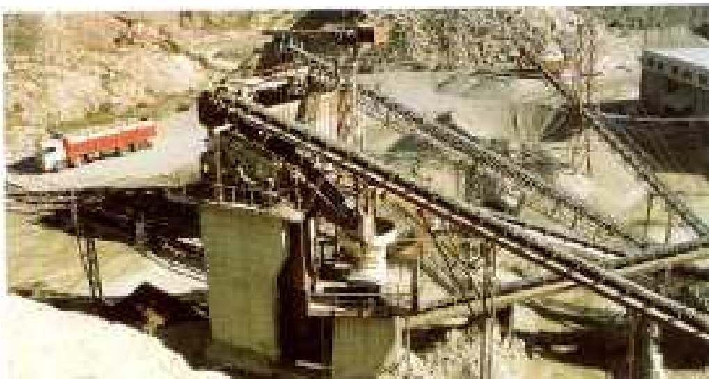
• Planta de tratamiento del material de la cantera.
