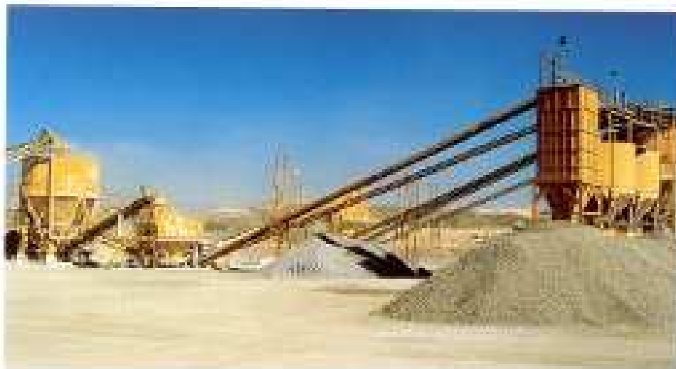
• Vista parcial de la planta de tratamiento de la explotación.
