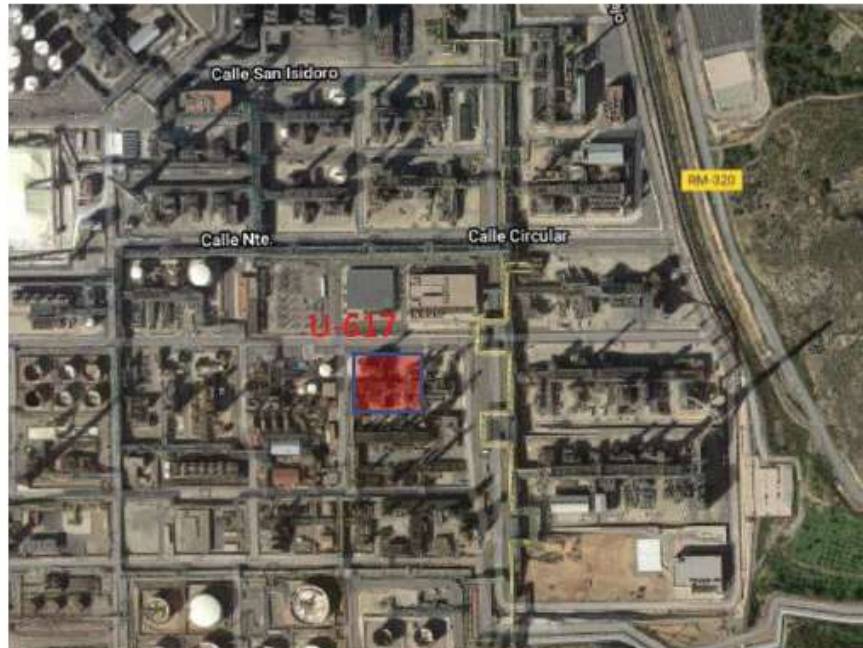
Situación de la unidad U617 dentro de la refinería
