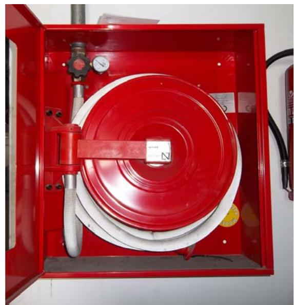
superficie del sector de incendio en que estén instaladas quede cubierta por una BIE, considerando como radio de acción de ésta la longitud de su manguera incrementada en 5 m.
