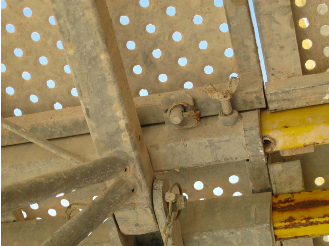
Imagen 8. Elementos de unión: pernos con pasadores en la fijación de los pisos de la plataforma a la estructura y entre módulos de plataformas y palometa en la unión de los extensibles. Suelo de chapa perforada para el drenaje.
