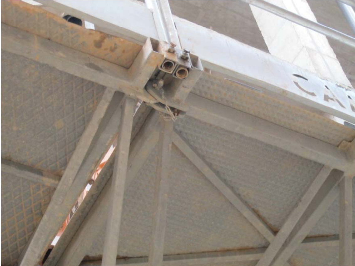
Imagen 9. Detalle de la fijación a la estructura de la barandilla exterior mediante tornillo de presión.
