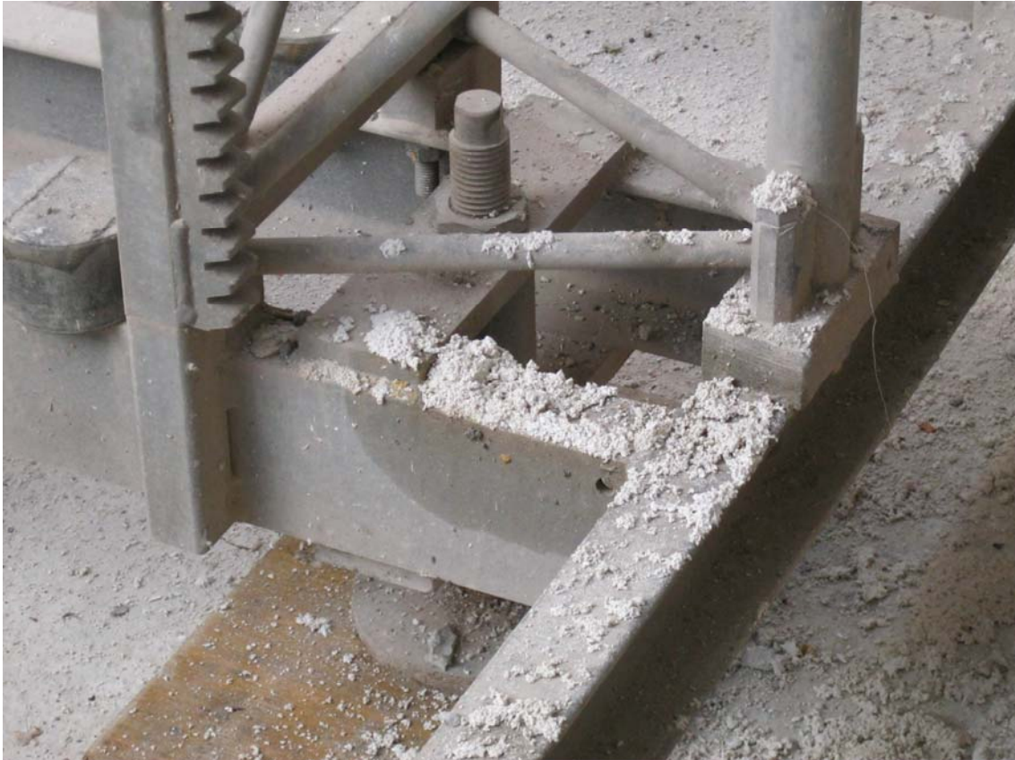
Imagen 2. Chasis fijo, con detalle del arranque del mástil.
