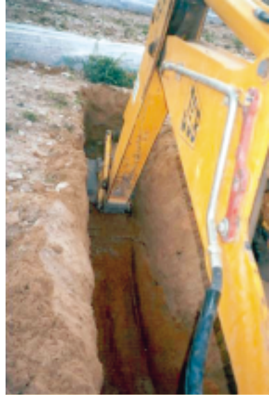
Figura 8. Retroexcavadora abriendo un perfil en el suelo.
