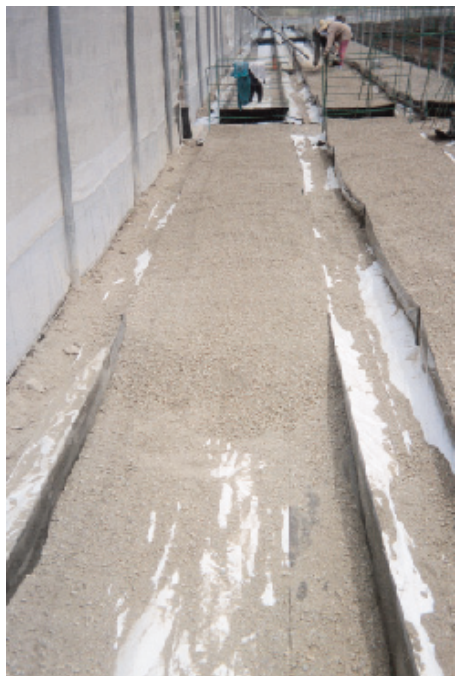
Llenado de la banqueta con arena.
