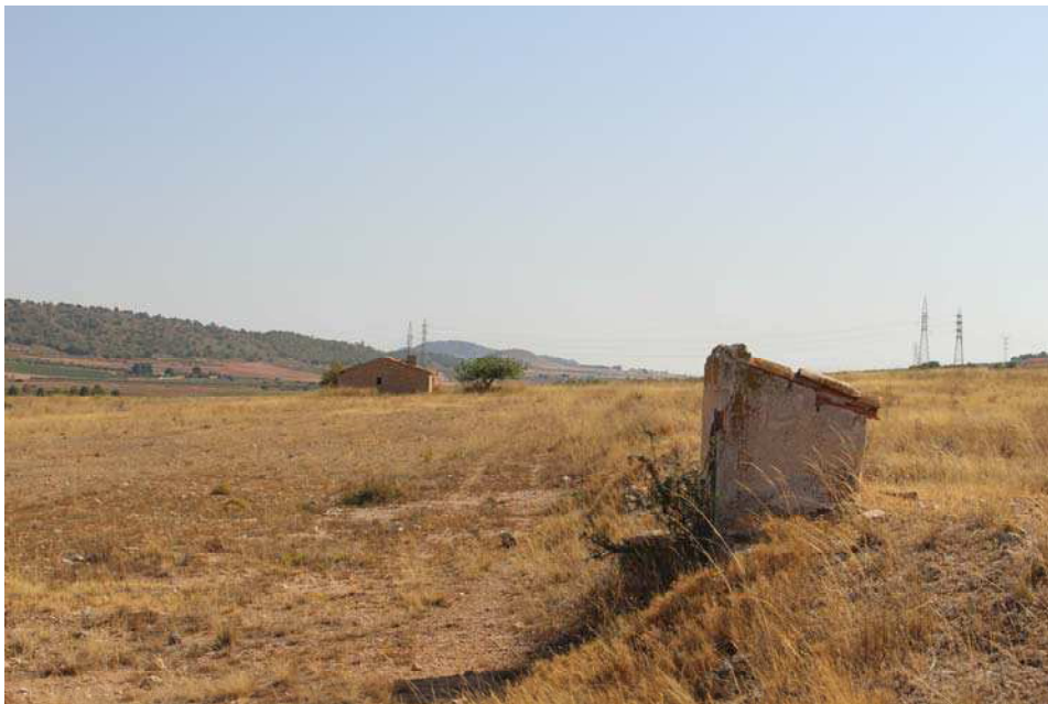
Fotografía 5. Vista desde el interior de la finca donde puede verse una casa y un aljibe identificados a estudiar antes del desmantelamiento de la parcela.
