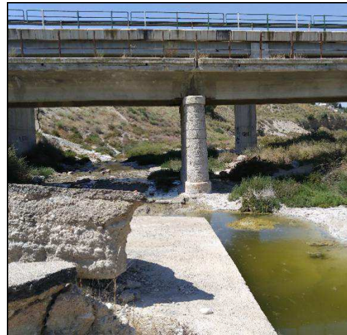
Figura 3 Cauce de Rambla Salada, a su paso bajo la carretera RM-423 de Fortuna, sobre la que discurre la mayor parte de la tubería.
