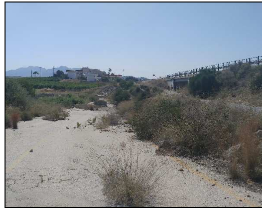
Figura 39 Carretera junto a la que discurrirá la tubería hacia el embalse nuevo, en dirección Sur-Norte
