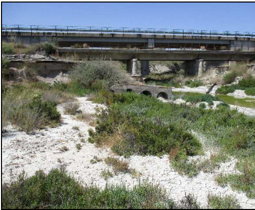
Figura 38 Carretera (al fondo) junto a la que discurrirá la tubería hacia el embalse nuevo, en el tramo bajo el cual discurre Rambla Salada.
