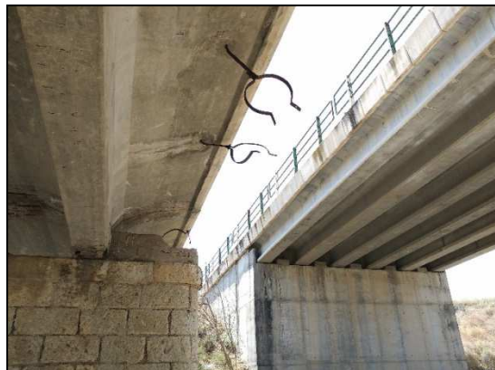
Figura 9 Restos de estructuras de sujeción de una infraestructura previa, que atravesaba el cauce del río sujeta al puente sobre el que discurría la antigua carretera (a la izquierda).
