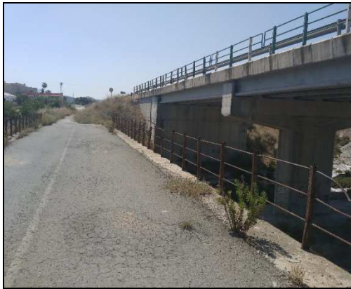
Figura 7 Puente a lo largo del que se acondicionará el paso de la tubería (Alternativa 2)
