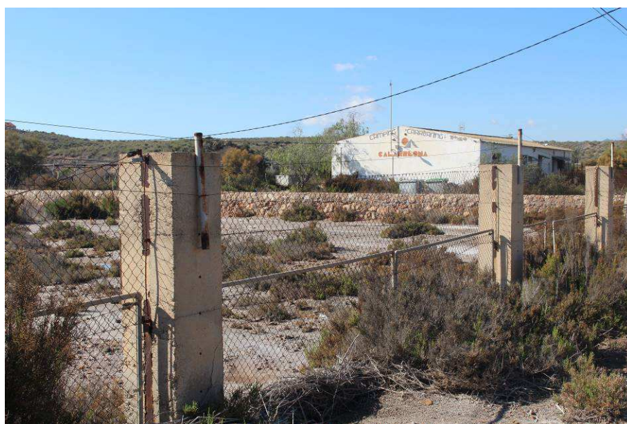
Figura 2. Vista de detalle del vallado de la finca a su paso por el cauce de la rambla de Cañada Brusca , que la atraviesa, aguas arriba.
