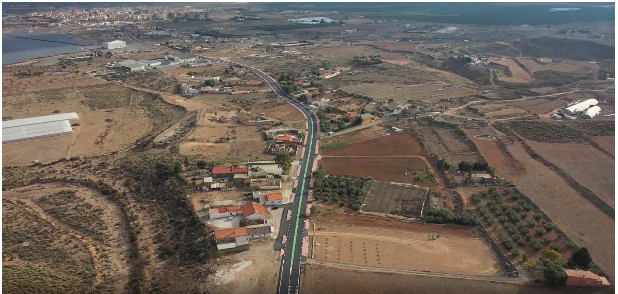
ACONDICIONAMIENTO DE CARRETERA RM-D17. ALMENDRICOS
