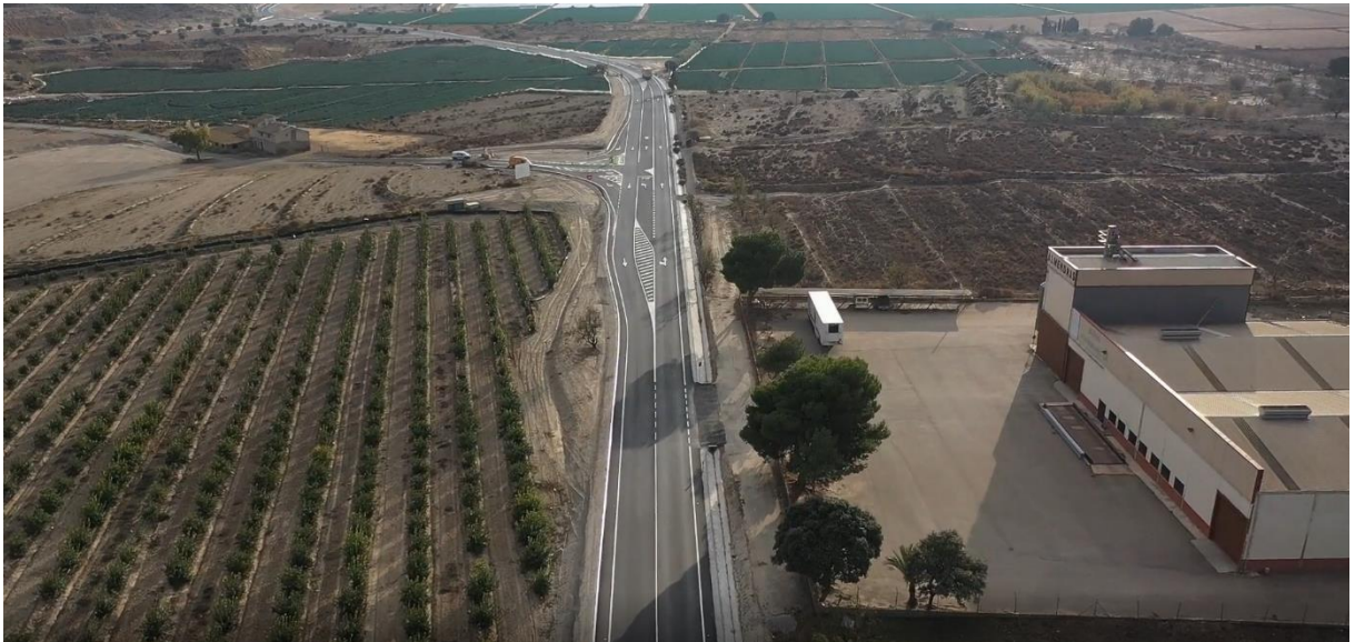
ACONDICIONAMIENTO DE CARRETERA RM-D17. ALMENDRICOS
