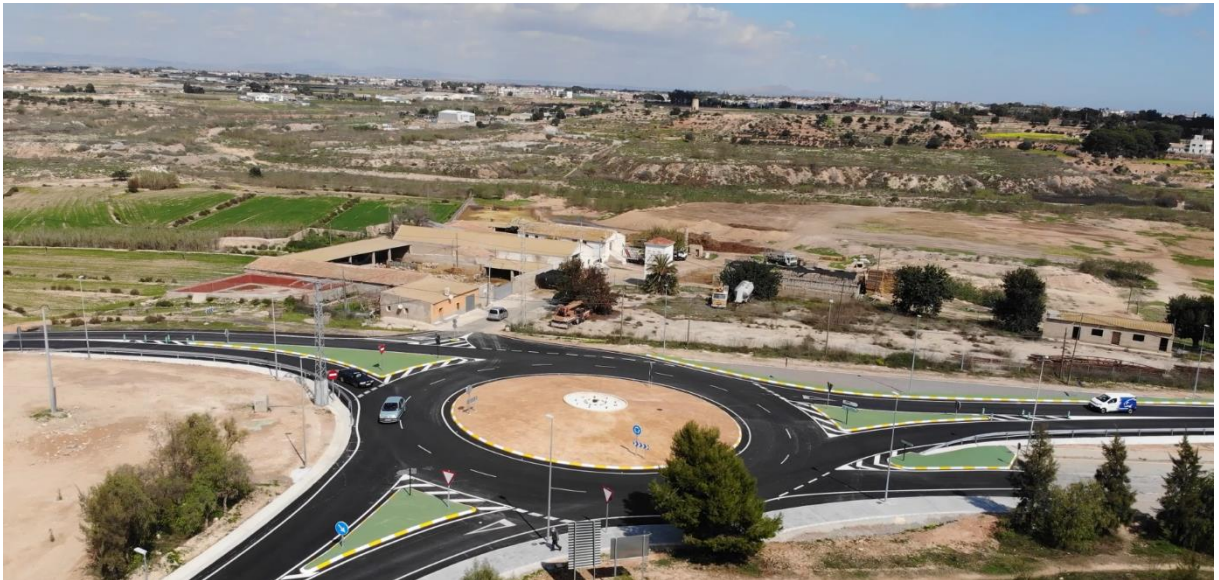
CONSTRUCCIÓN DE GLORIETA EN VIÑA DEL MAR
