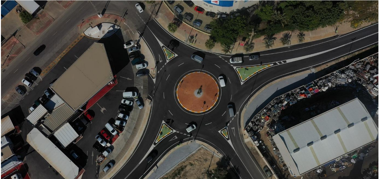
ACONDICIONAMIENTO DE CARRIL DE LOS SOLDADOS RM-E4
