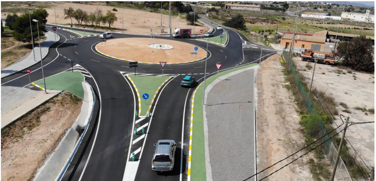
CONSTRUCCIÓN DE GLORIETA EN VIÑA DEL MAR
