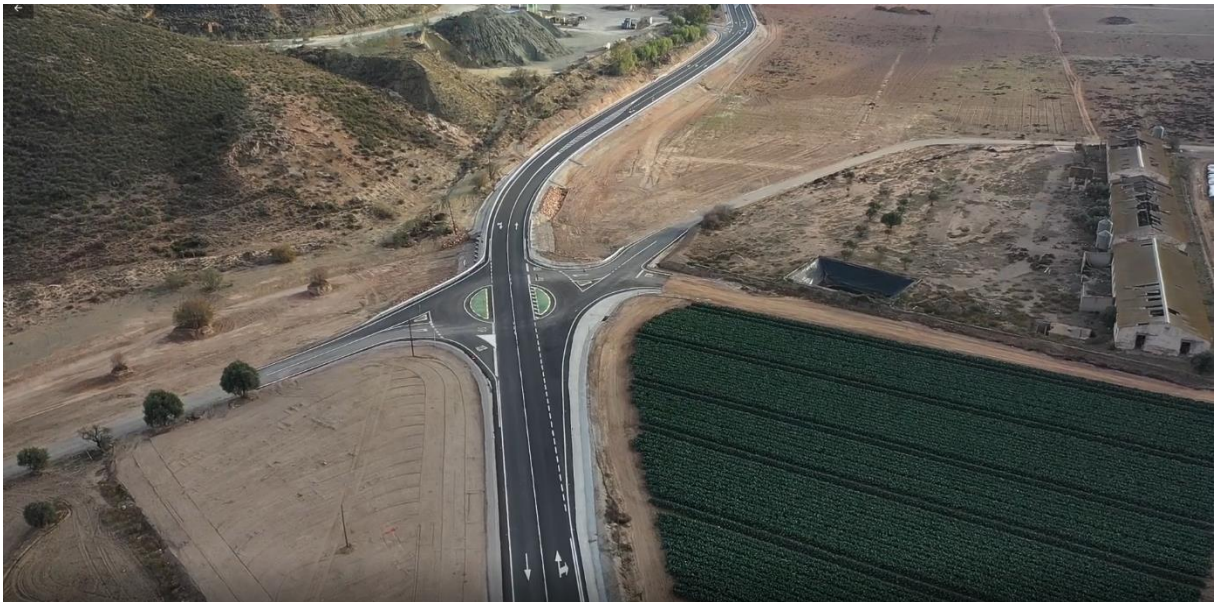
ACONDICIONAMIENTO DE CARRETERA RM-D17. ALMENDRICOS
