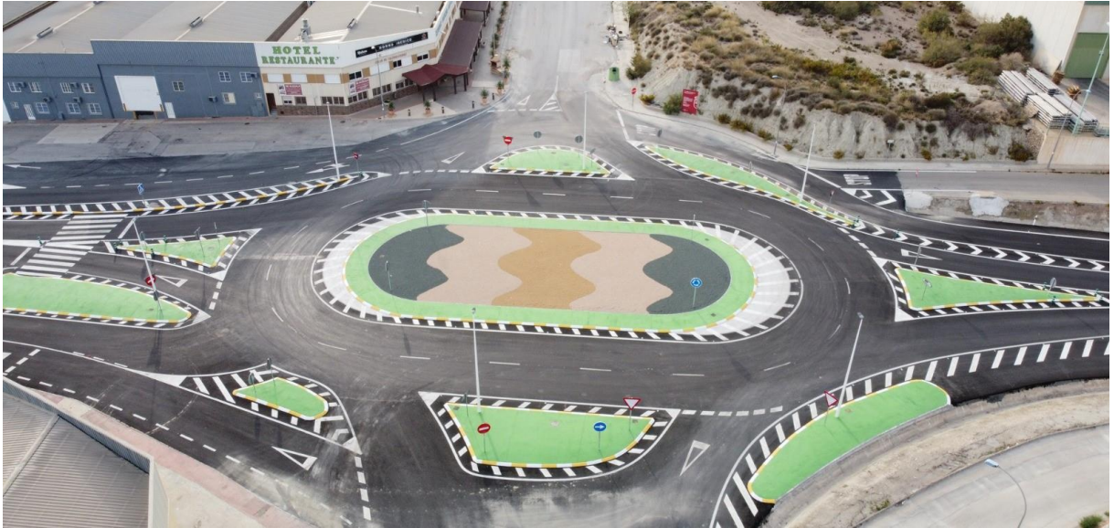
CONSTRUCCIÓN DE GLORIETA. ABANILLA
