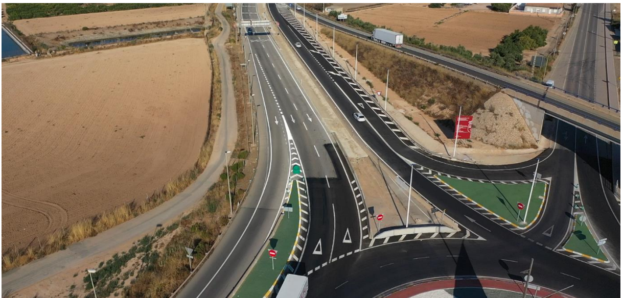
CONSTRUCCIÓN DE GLORIETA EN CARRETERA RM-19. POZO ALEDO
