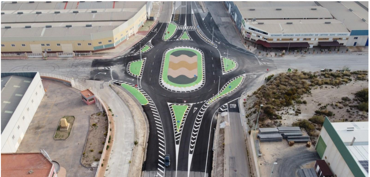
CONSTRUCCIÓN DE GLORIETA. ABANILLA
