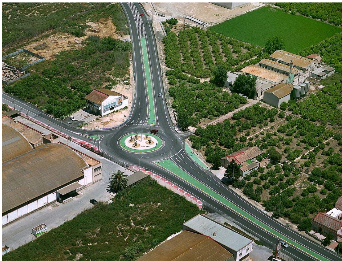
CONSTRUCCION DE GLORIETA EN RM-333 CON TRAVESIA DE ALQUERIAS
