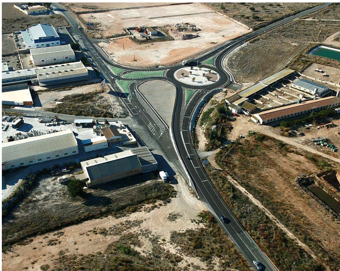
GLORIETA EN RM-602 CUATRO VIENTOS EN FUENTE ALAMO
