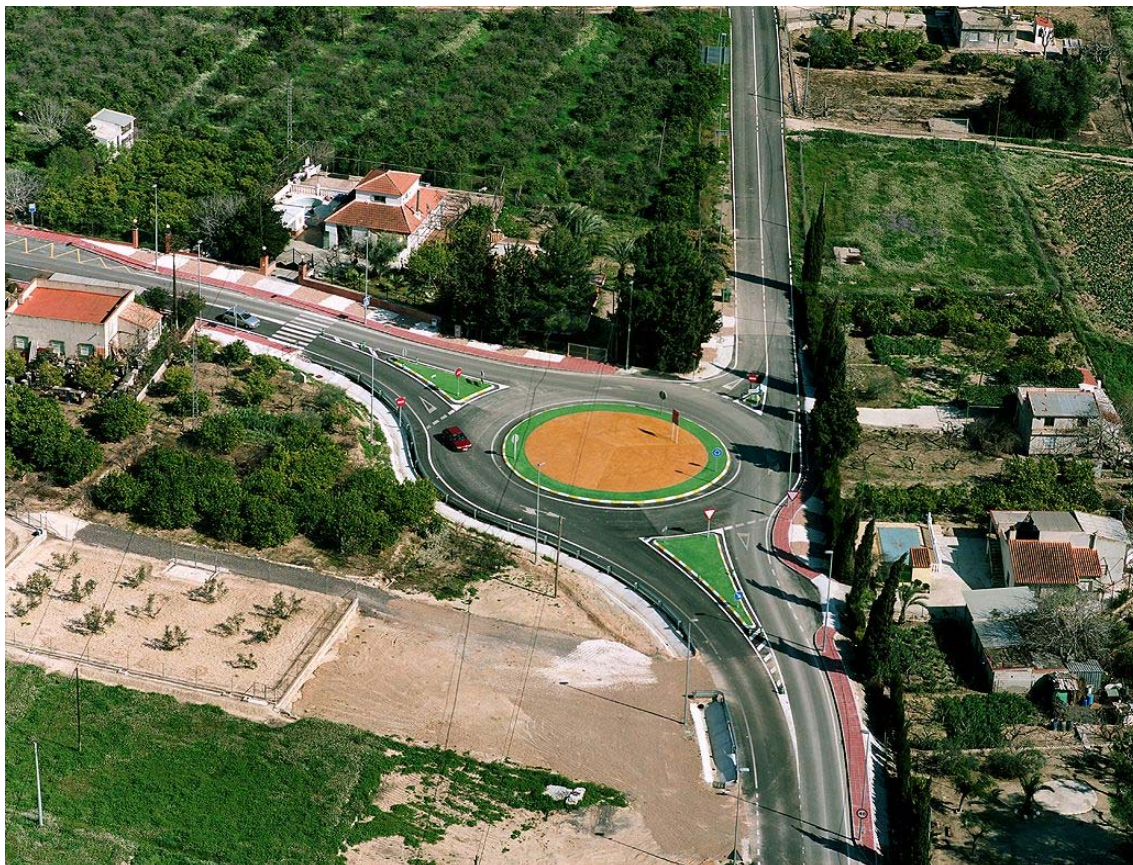
CONSTRUCCIÓN DE GLORIETA EN RM-B6 CON CAMINO DE TORRE MONTIJO MOLINA DE SEGURA
