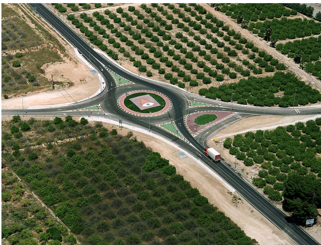
CONSTRUCCIÓN DE GLORIETA EN CTRA. RM-414 P.K. 2,5. SANTOMERA
