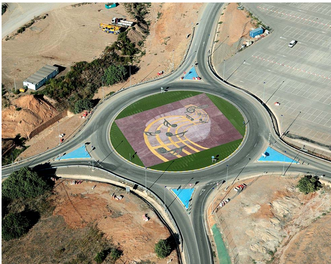
CONSTRUCCIÓN DE GLORIETA EN INTERSECCIÓN DE CTAS. RM-320 Y RM-322. ESCOMBRERAS
