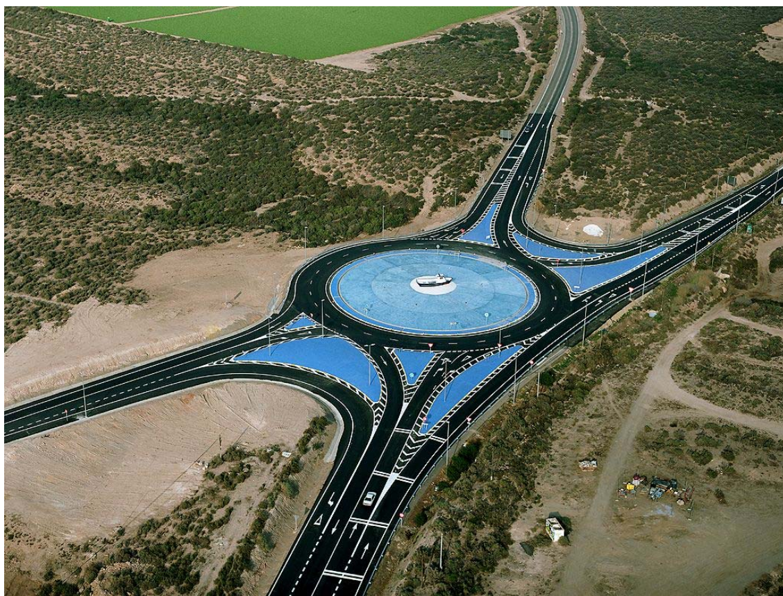
CONSTRUCCIÓN DE GLORIETA EN CTRA. RM-333 Y RM D18 EN AGUILAS
