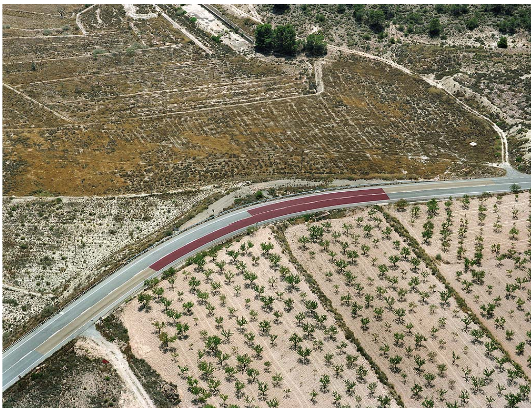
PAVIMENTOS ANTIDESLIZANTES EN TRAMOS CURVOS
