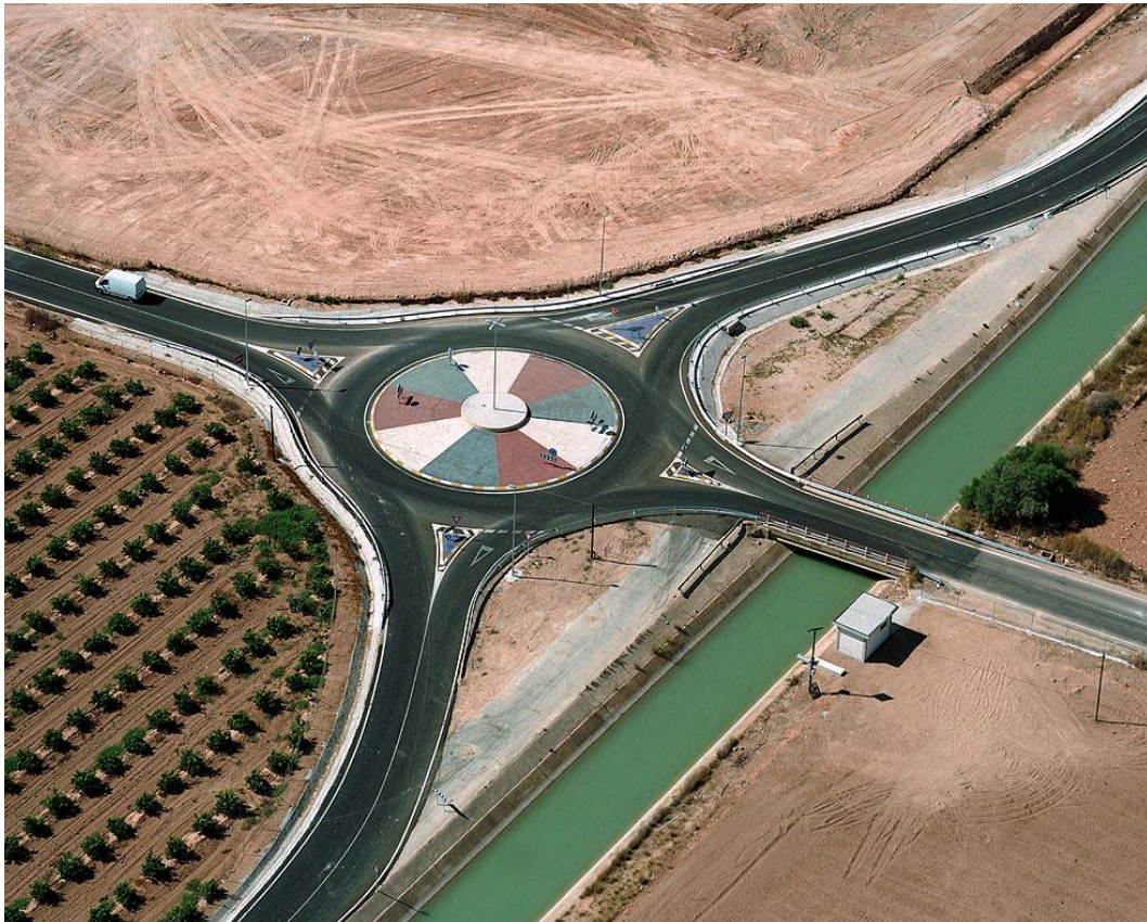
CONSTRUCCIÓN DE GLORIETA EN INTERSECCIÓN DE CTRA. F-25 CON CAMINO DE SERVICIO DEL TRASFASE TAJO-SEGURA.
