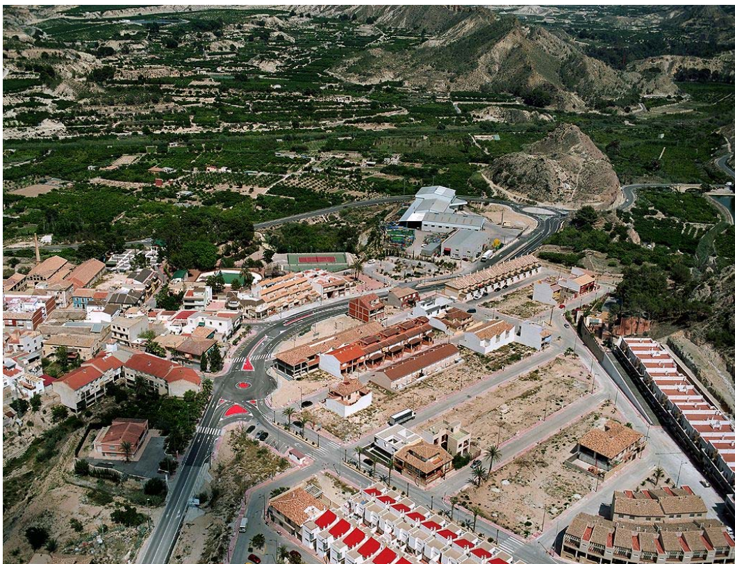
ACONDICIONAMIENTO DE TRAVESÍA EN VILLANUEVA DEL RÍO SEGURA.
