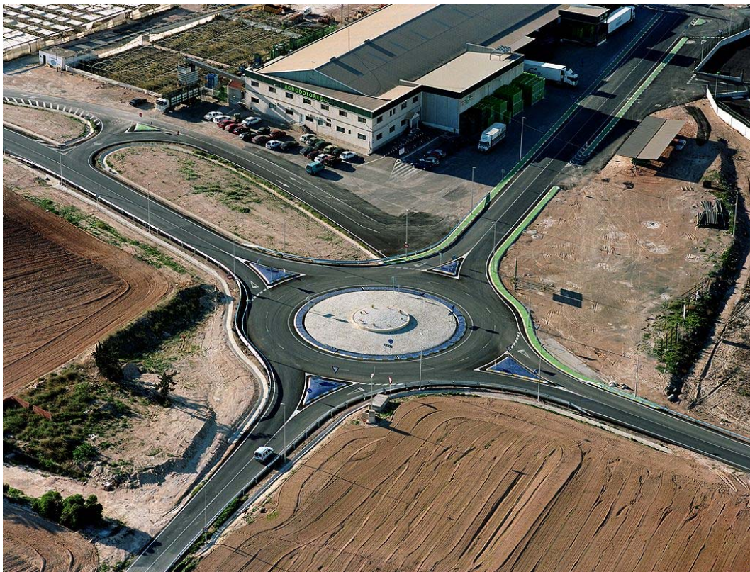
CONSTRUCCIÓN DE GLORIETA EN INTERSECCIÓN DE CTRAS. F-27 Y F-28.
