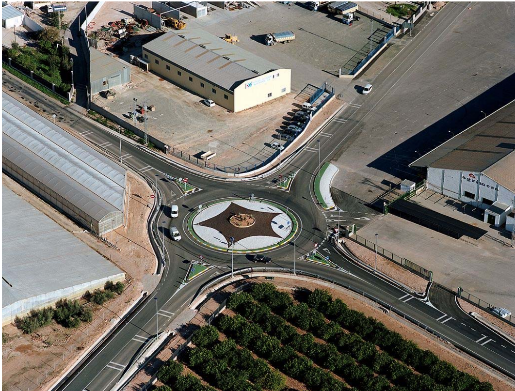
CONSTRUCCIÓN DE GLORIETA EN LA INTERSECCIÓN DE CARRETERAS F-48 Y F-23.
