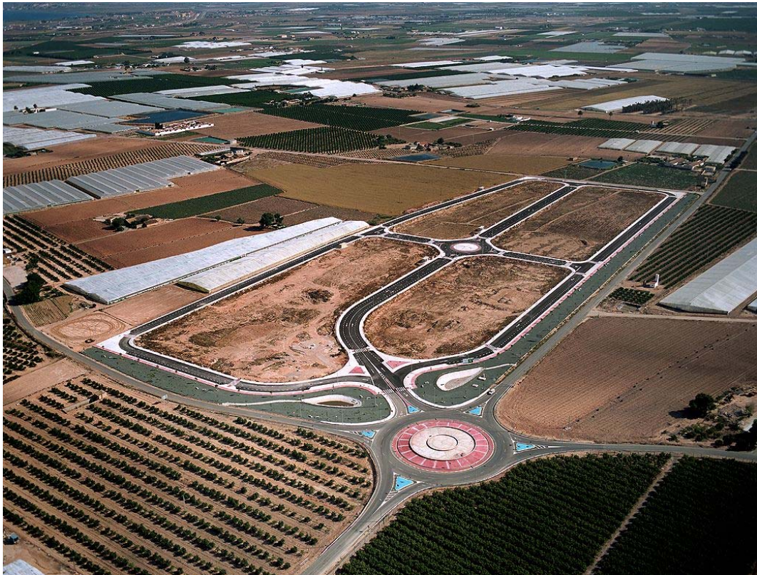
CONSTRUCCIÓN DE GLORIETA EN INTERSECCIÓN DE CTRAS. F-28 Y F-29.
