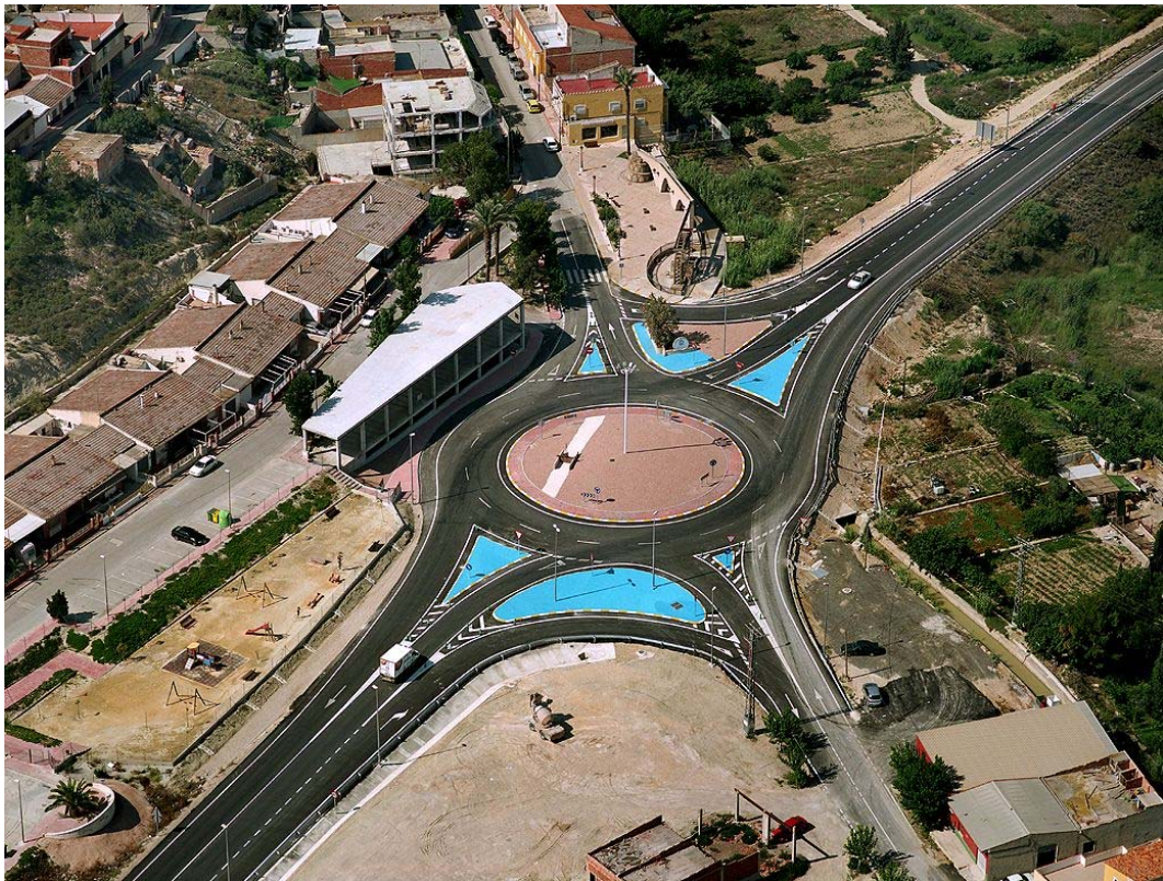
CONSTRUCCIÓN DE GLORIETA EN CTRA. B-33.
