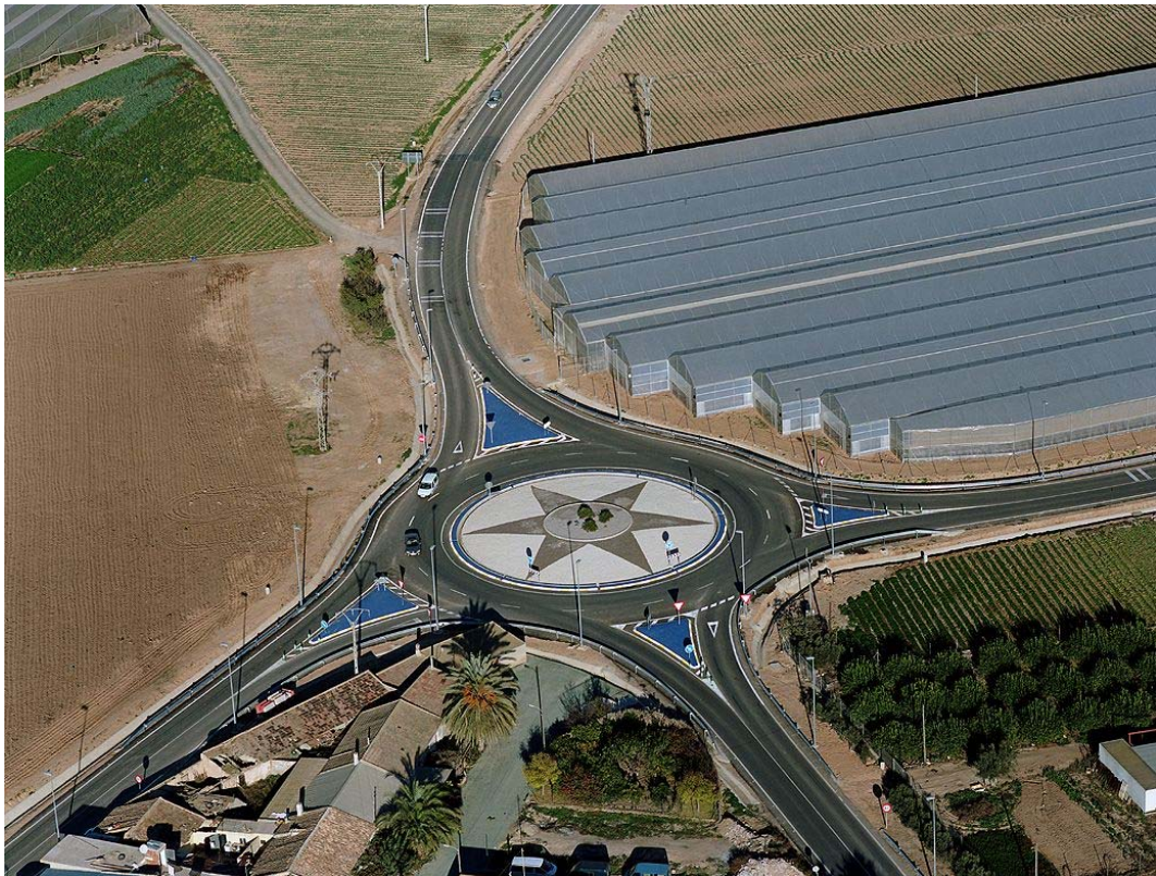
CONSTRUCCIÓN DE GLORIETA EN INTERSECCIÓN DE CTRAS. F-35 Y F-26.
