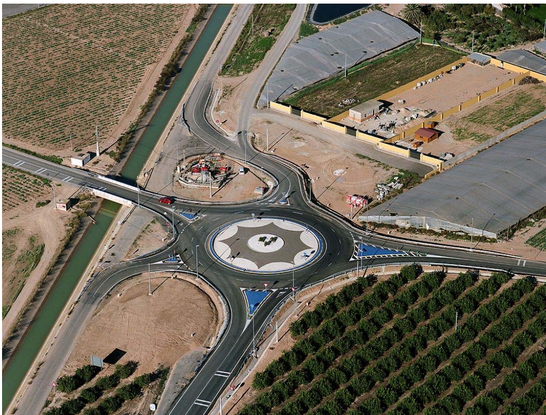
CONSTRUCCIÓN DE GLORIETA EN INTERSECCIÓN DE CARRETERAS F-22 Y F-26.
