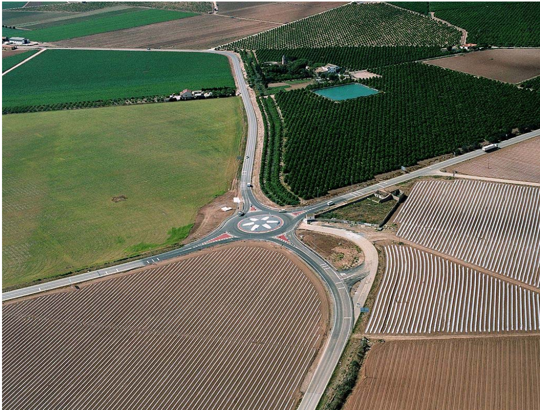
CONSTRUCCIÓN DE GLORIETAS EN INTERSECCIÓN DE CTRAS. F-35 Y F-37.
