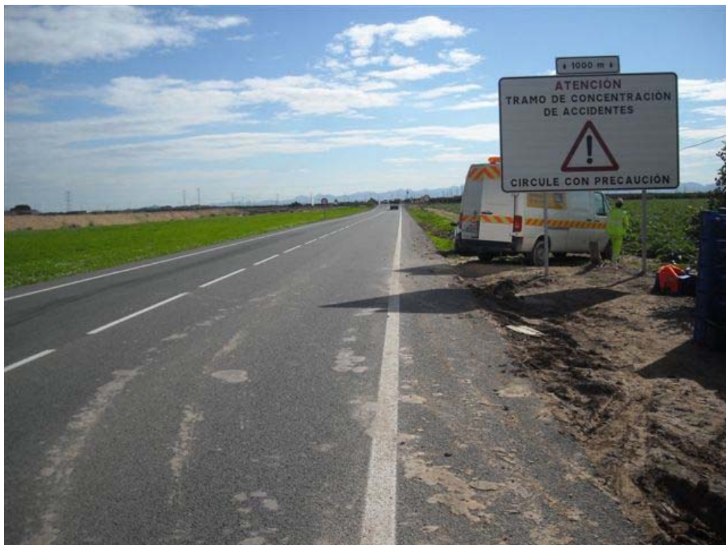
SEÑALIZACIÓN DE TRAMOS DE CONCENTRACIÓN DE ACCIDENTES.
