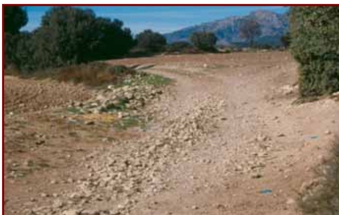
Tramo REVERMED a su paso por Collado Almacilón
