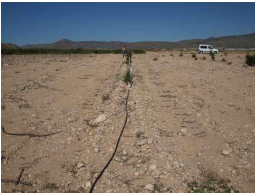
Instalación de aspersores
