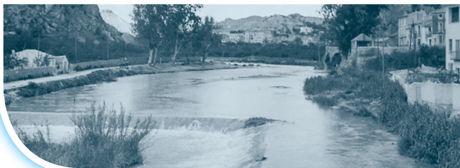
Presa de derivación hacia molino harinero (El Ciecón)
