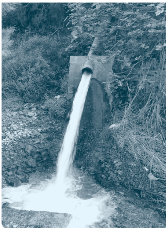
Aliviadero de la Acequia 'Charrara'
