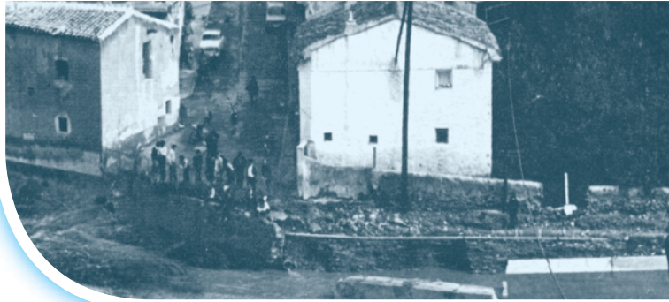
Efectos de la riada en el dique
