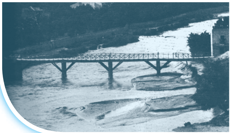
Puente de madera sobre el Segura, destruido por la riada 'La Bendita'
