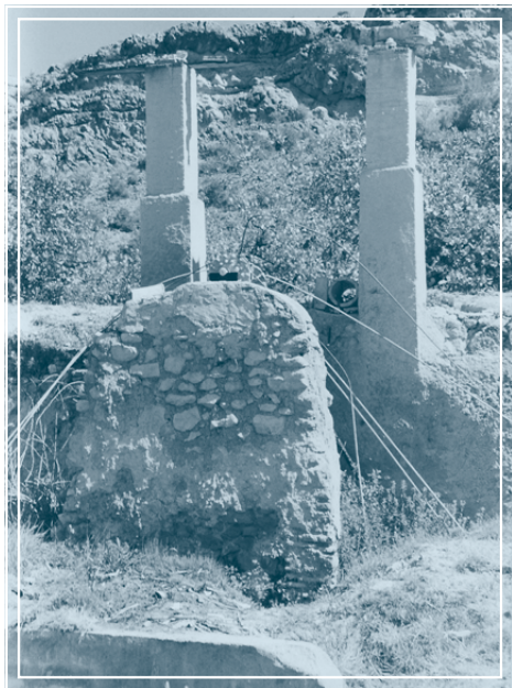
Canal de agua y restos de la noria de 'Miguelico Nuñez', que regaba de entre 4 y 5 tahúllas
