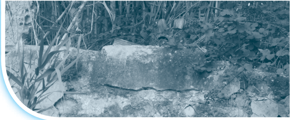
Detalle del apoyo del eje de la noria de la "Viuda de Juan de Teodoro"
