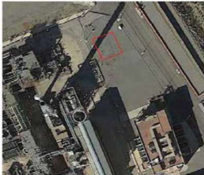
Ubicación del compresor U-604 dentro de la refinería
