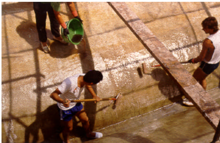
Figura 1.4 Proceso de laminación manual.
