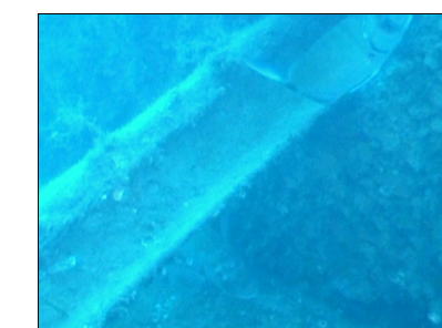
Foto 12. Detalle de una de las vigas.
