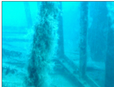
Foto 56. Diversas estructuras depositadas sobre el fondo.
