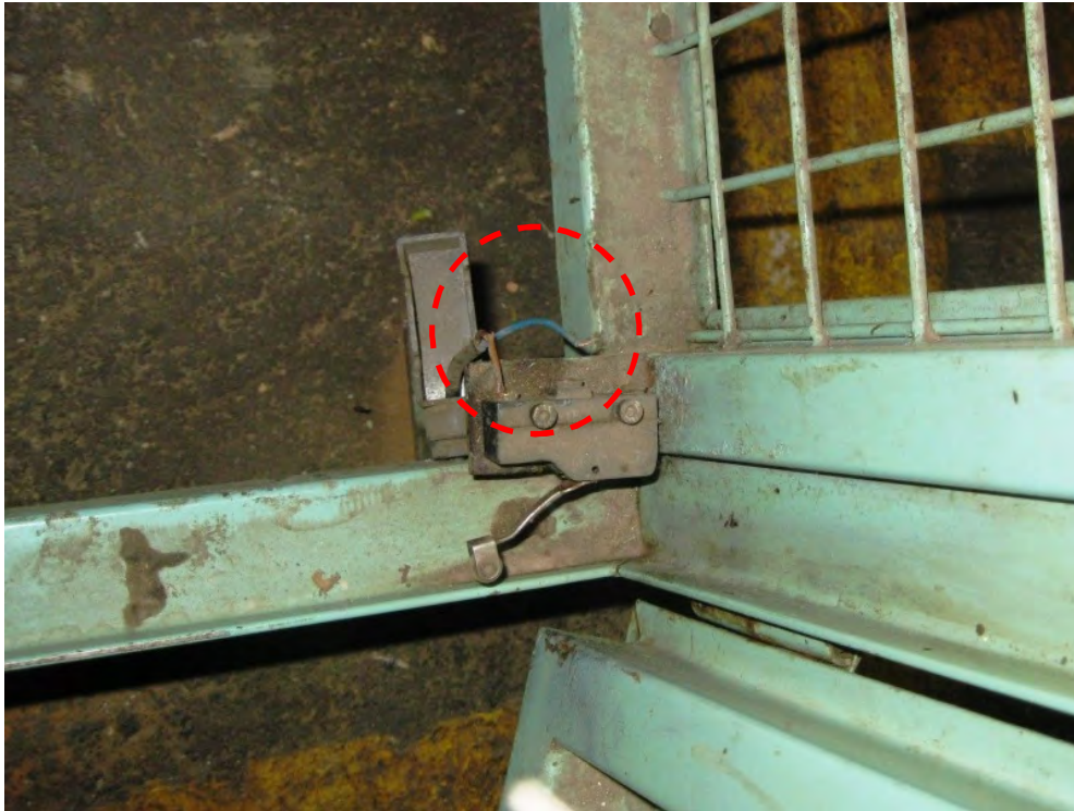
Figura 9. Anulación de un dispositivo de enclavamiento eléctrico asociado a un resguardo móvil de un Despaletizador
