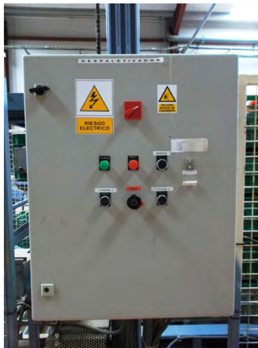
Figura 4. Órganos de accionamiento Despaletizador
