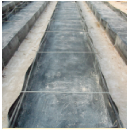
Banquetas preparadas para su llenado.
