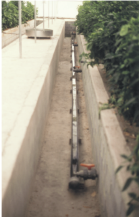
Detalle del foso de recogida de drenajes.
