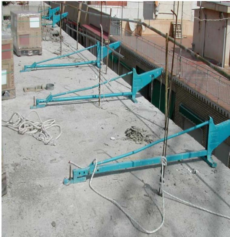
Estructura de suspensión mediante pescantes anclados al forjado
