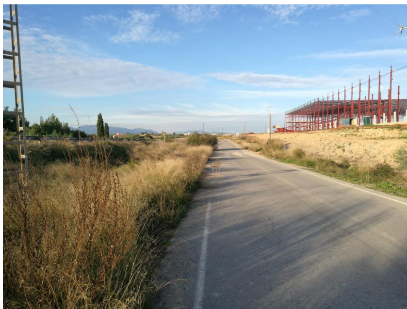
Fig. 4. Ejemplar de Tamarix canariensis en el margen izquierdo de la carretera frente a la nave en construcción.
