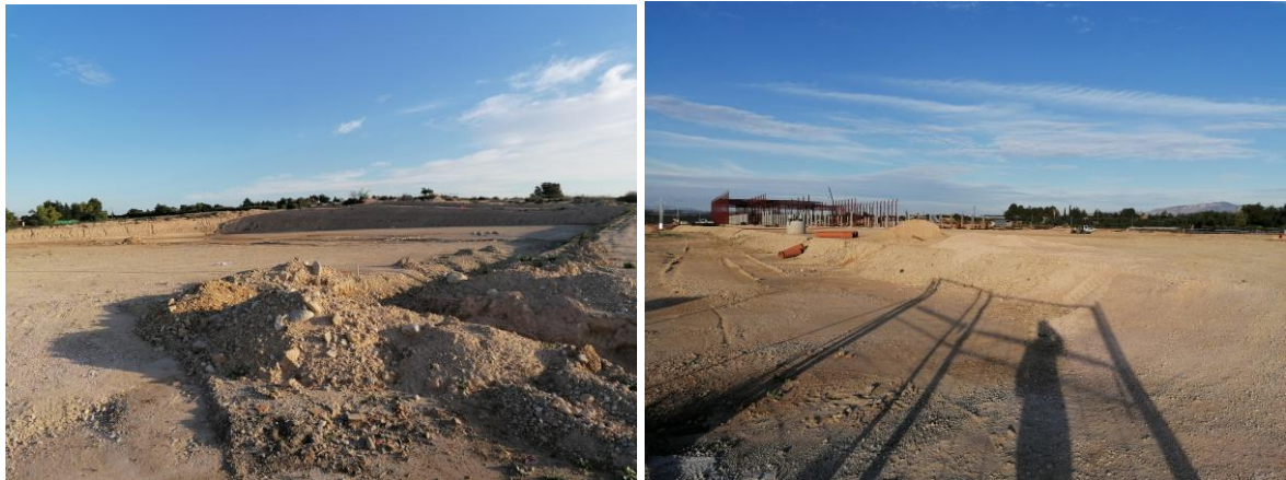
Fig. 2. Aspecto actual de la zona de actuación, con movimientos de terreno realizados y nave en construcción.
