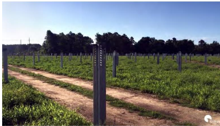
Figura 3. Seguidores hincados en el suelo
