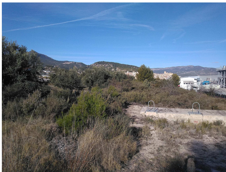
Fig. 4. Vegetación asociada a la traza del Canal de la Mancomunidad de los Canales del Taibilla.
