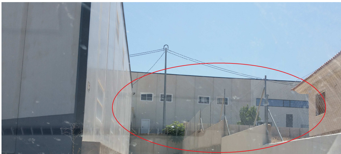
Imagen 4: Infraestructura construida en virtud de la declaración de interés social SNU: 36/32014
