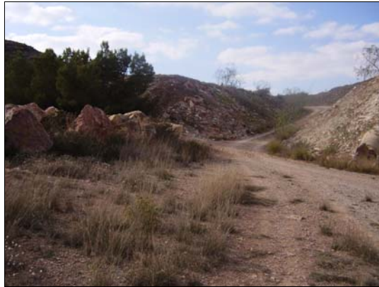
FOTO 4 Vista general de los taludes del ver tadero nº 4.
