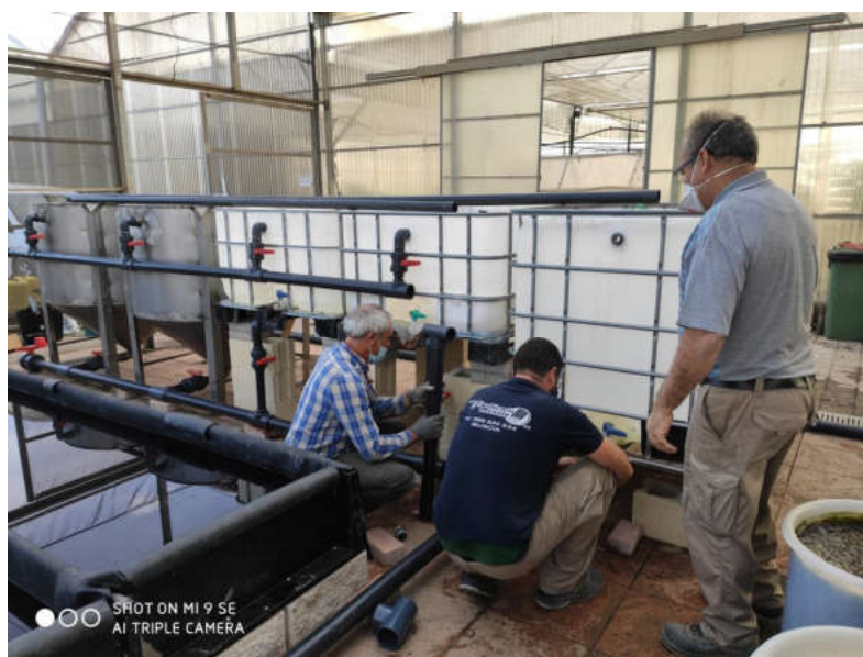
Instalación de nuevos depósitos (30/11/2020)
