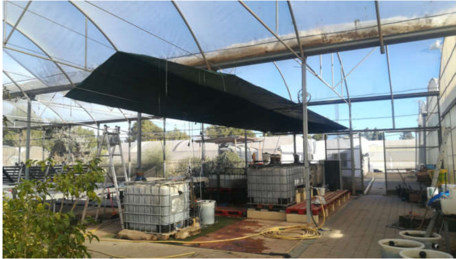
Aspecto general de la nueva planta
