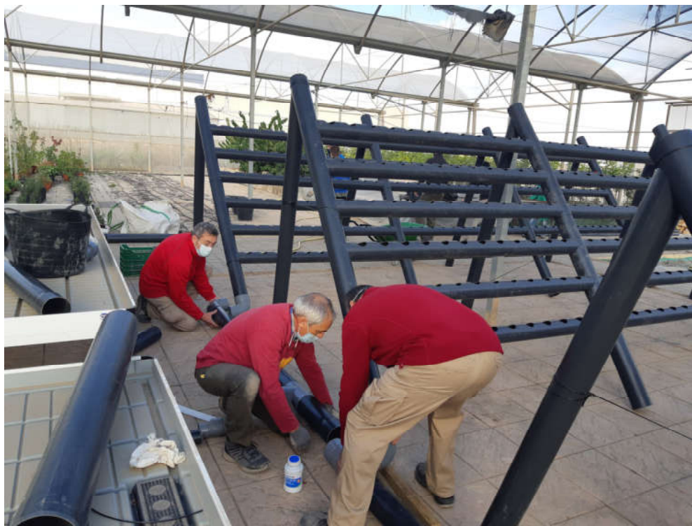
Instalación de gradas horizontales (11/11/2020)
