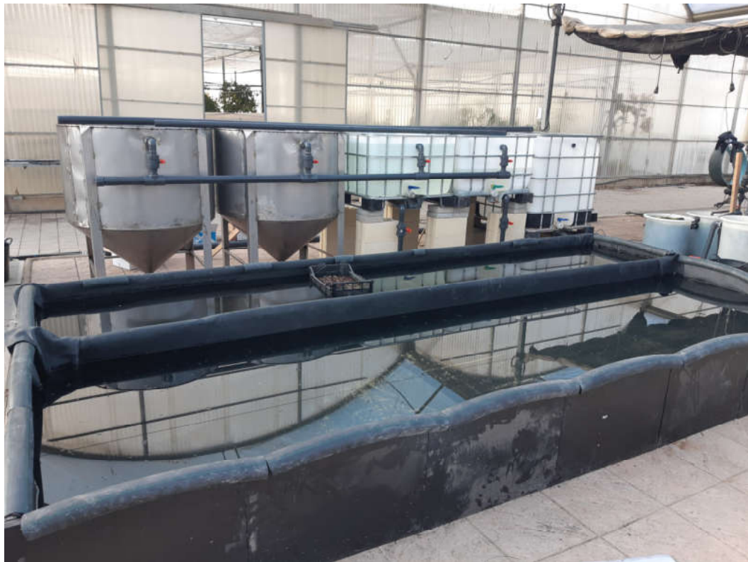
Instalación de nuevos depósitos de metal y plástico
