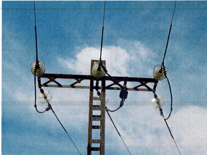
Cruceta recta con puente ecológico aislado.
