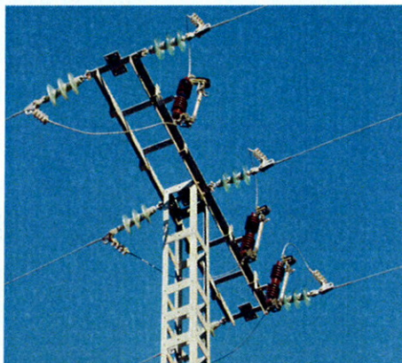
Apoyo con fusibles-seccionadores XS
