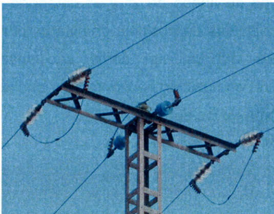
Apoyos con puentes flojos por encima de la cruceta, empleando aisladores rígidos
