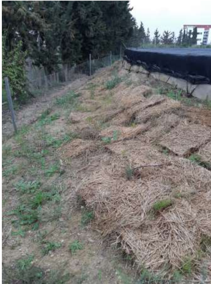
Foto nº 21. Prevención de erosión con mulching de paja en talud de embalse (18/02/2020).
