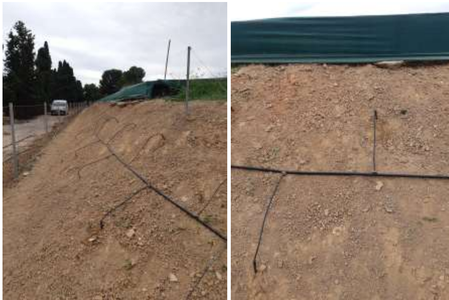
Fotos nº 11 y 12. Instalación de los microtubos para riego y detalle de los mismos (14/11/2019).
