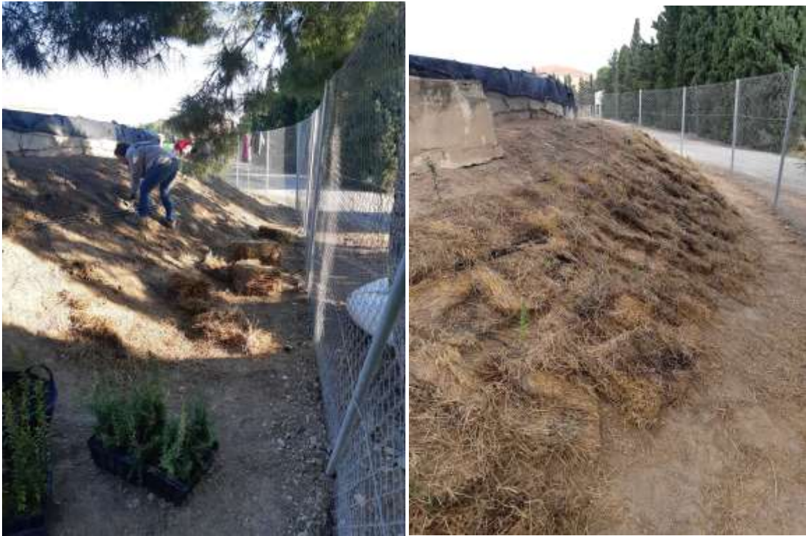
Fotos nº 14 y 15. Plantación de los taludes y aspecto del mulching de paja (20/11/2019).
