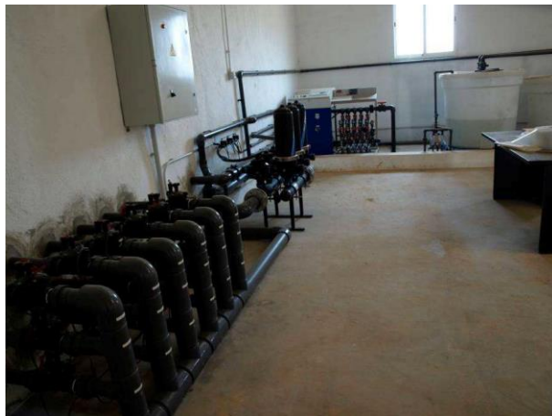
Cabezal de riego de Las Nogueras de Arriba.
